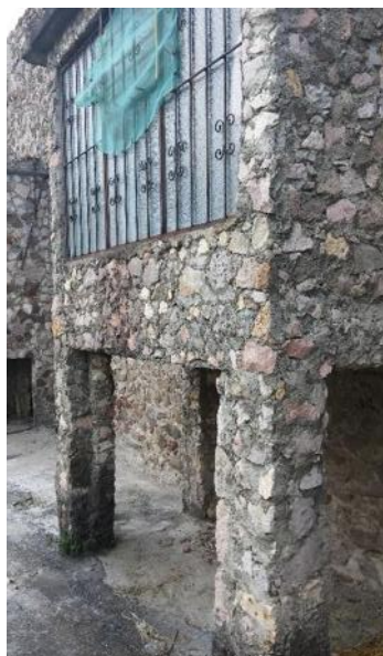
Figura 198: Baño anexo a celdas 218
