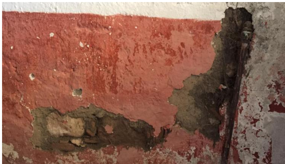
Figura 46: Aplanado a base de arcilla en muro de celda 105
