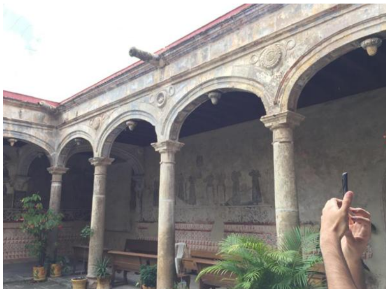
Figura 28: Levantamiento fotográfico de cubiertas 82
