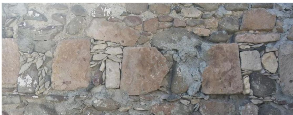
Figura 70: Trabajo de mampostería en el muro externo de las celdas
