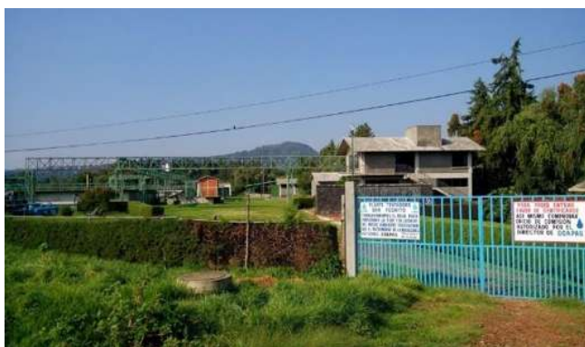
Figura 4.5 Planta de tratamiento de agua residual "San Pedrito", Pátzcuaro, Michoacán.
