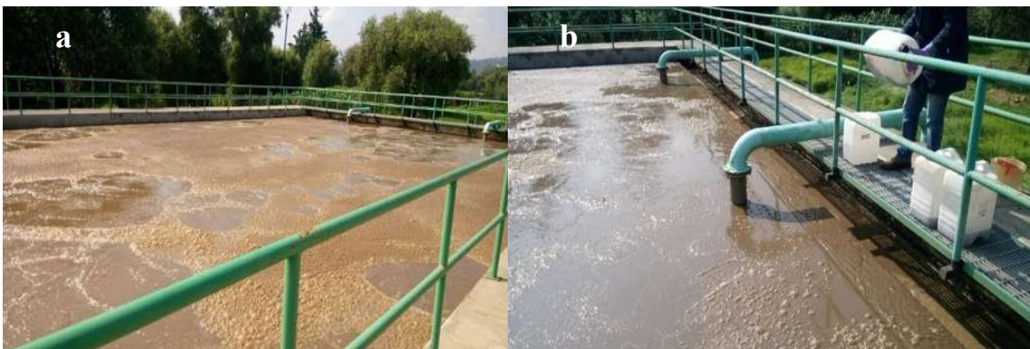
Figura 4-8 a). Reactor biológico dos de la PTAR “San Pedrito”, Pátzcuaro, Michoacán. b). Toma muestra de lodos del reactor biológico
