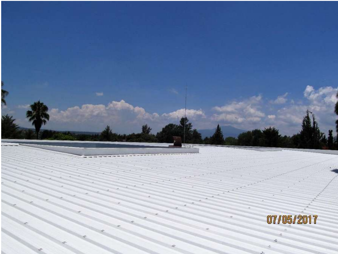
Figura 23. Cubierta del tercer nivel, edificio “C (fuente: autor).
