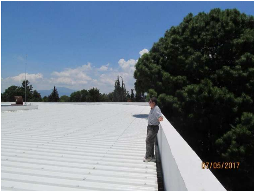
Figura 26. Canaleta metálica adosada al techo (lado derecho inferior). (Fuente: autor).
