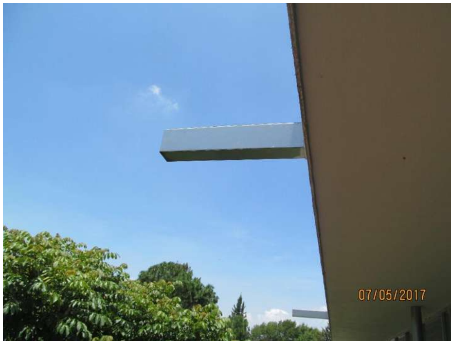
Figura 30. Tronera de PVC con lámina galvanizada (fuente: autor).
