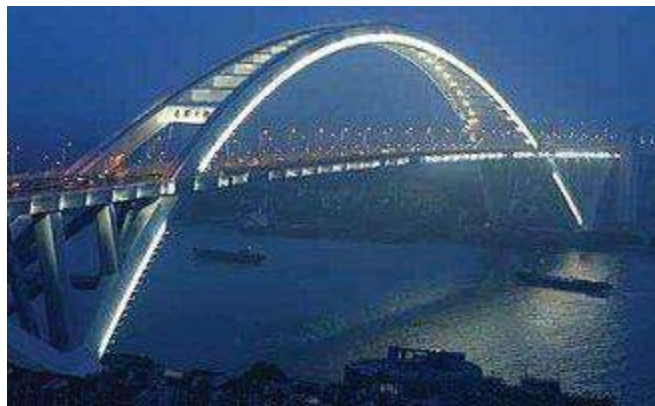
Figura 1.2 El Puente Lupu ( http://www.google-earth.es/ )
