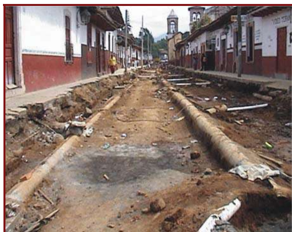
Ilustración 46. Mejoramiento de calles, drenajes y banquetas en el marco del Programa Pátzcuaro Pueblos Mágico.
