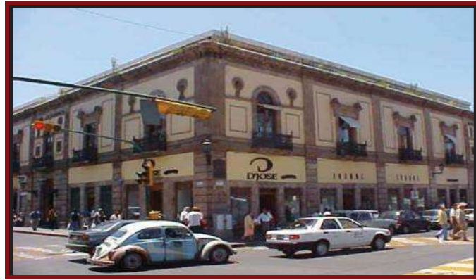
Imagen 21: Hotel Los Juaninos . Fachada exterior con un tercer nivel como agregado.
