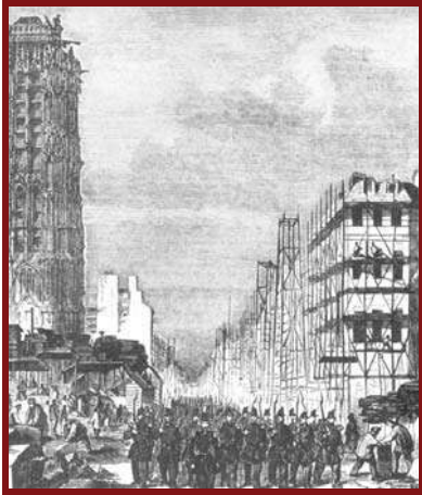
Ilustración 12: Trabajos de la apertura de la Rue du Rivoli cerca del Hotel de Ville (Ayuntamiento) en París hacia el año de 1854. (Ilustración aparecida en el London News , el 7 de enero de 1854).
