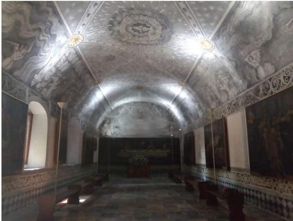
Antigua Sacristía (Actual Pinacoteca) (Imagen 62)
