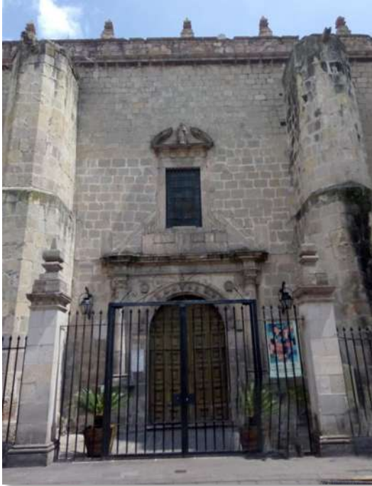
Fachada lateral norte del templo (Imagen 18)
