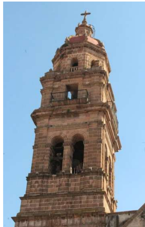
Torre norte (Imagen 17)
