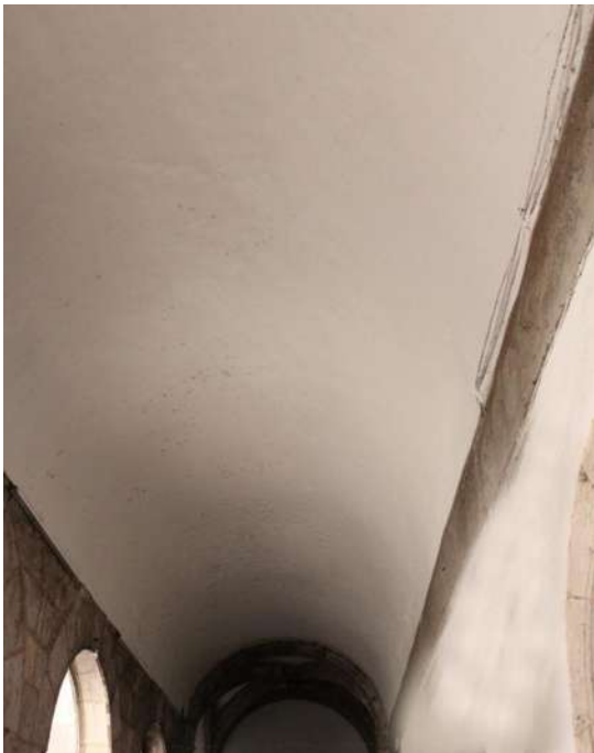
Bóveda de cañón corrido de los pasillos del claustro bajo (Imagen 28)
