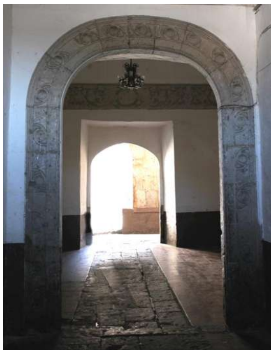
Entrada al vestíbulo (Imagen 25)
