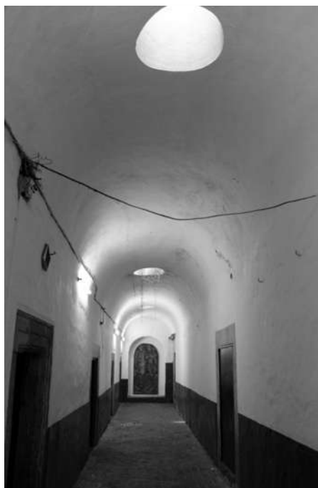
Pasillo de las celdas con bóveda de cañón corrido (Imagen 32)
