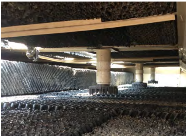
Figura 27. Muestra el diseño actual del aspersor de la torre tower tech y el relleno.
