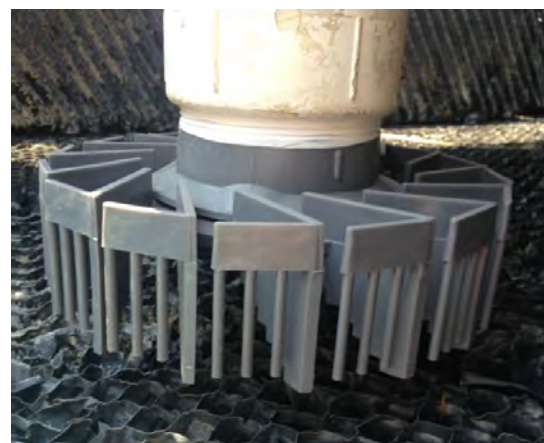
Figura 27. Muestra el diseño actual del aspersor de la torre tower tech y el relleno.
