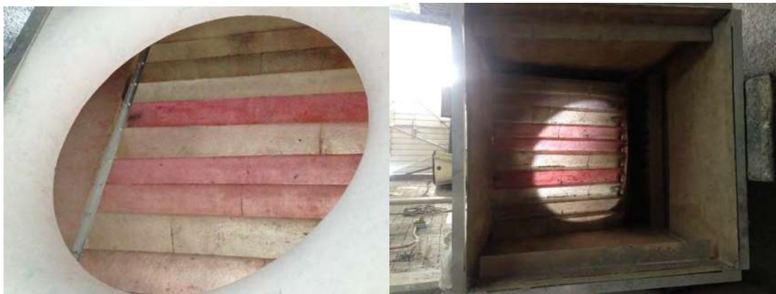
Figura 97. Montaje de difusor aire-agua dentro de la torre de enfriamiento, b) empotrado de los soportes de fijación.
