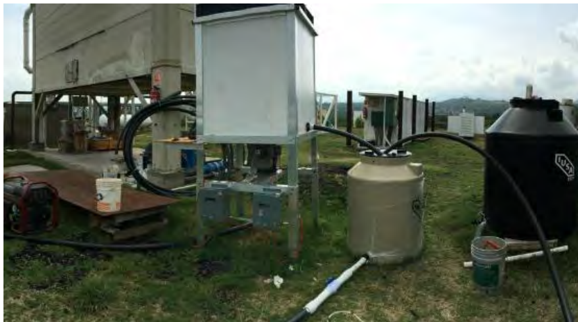
Figura 118. Montaje de la torre de enfriamiento para caracterización de la torre de enfriamiento.
