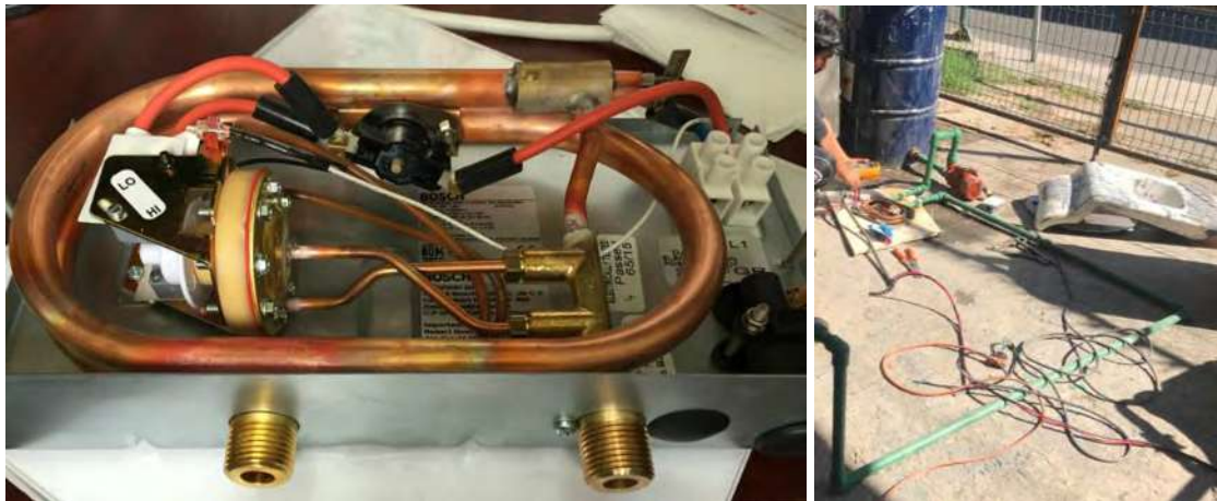
Figura 125. Montaje de la torre de enfriamiento para pruebas de rendimiento de propuestas del aspersor.
