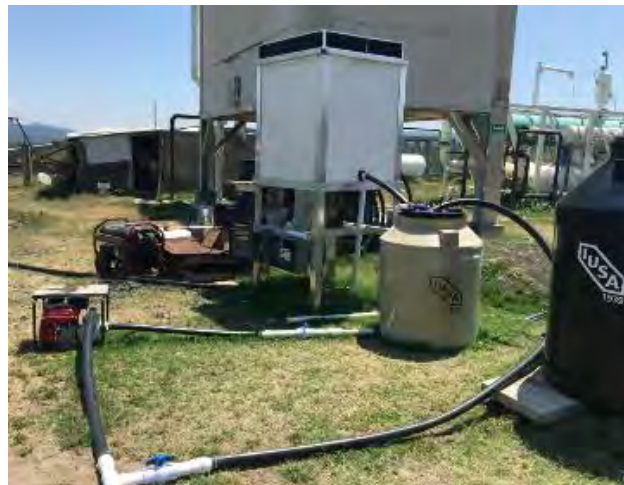
Figura 98. Torre de enfriamiento terminada y puesta para su arranque y pruebas.
