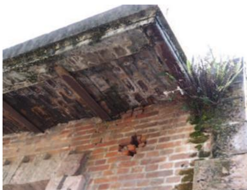
IMAGEN 143 y 144. El estado de los muros que presenta el edificio al exterior del inmueble. Fotos: AEZL.
