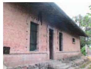
F-MAT-032 MURO DE CANTERIA
