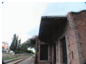
F-MAT-015 MURO DE LADRILLO
