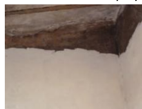
F-MAT-004 MURO INTERIOR TOMADA POR: AEZL. FECHA: 29/DIC/2011
