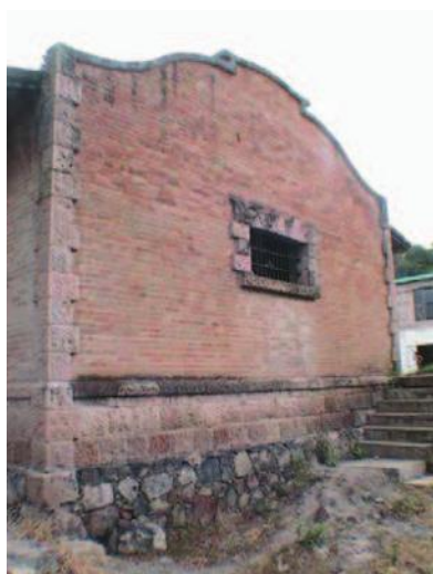
IMAGEN 112 y 113. Cimentación perimetral del edificio. Foto: AEZL.
