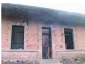
F-MAT-033 MURO DE LADRILLO
