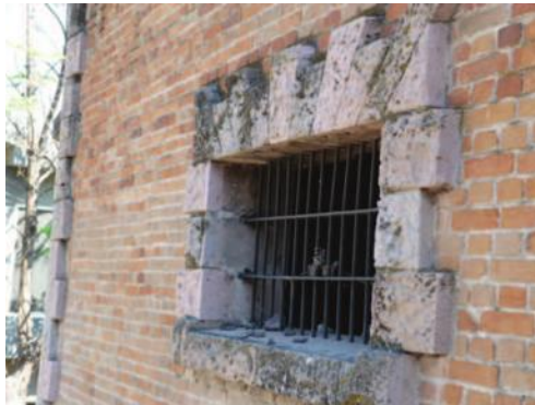
IMAGEN 066 y 067. En las imágenes se observa el enmarcamiento de cantería labrada en puertas y ventadas. Fotos: AEZL.
