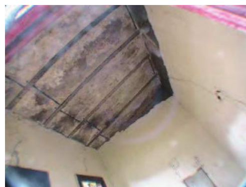
IMAGEN 062 y 063. En las imágenes se puede observar que el sistema constructivo de la cubierta está constituido por una bóveda escarzana. Fotos: AEZL.
