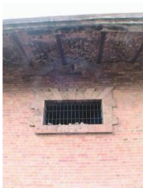
Imagen 052, 053 y 054. Se aprecia el enmarcamiento a base de cantería en puertas y ventanas. Fotos: AEZL.
