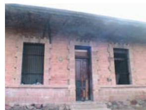
F-MAT-040 MURO DE CANTERIA
