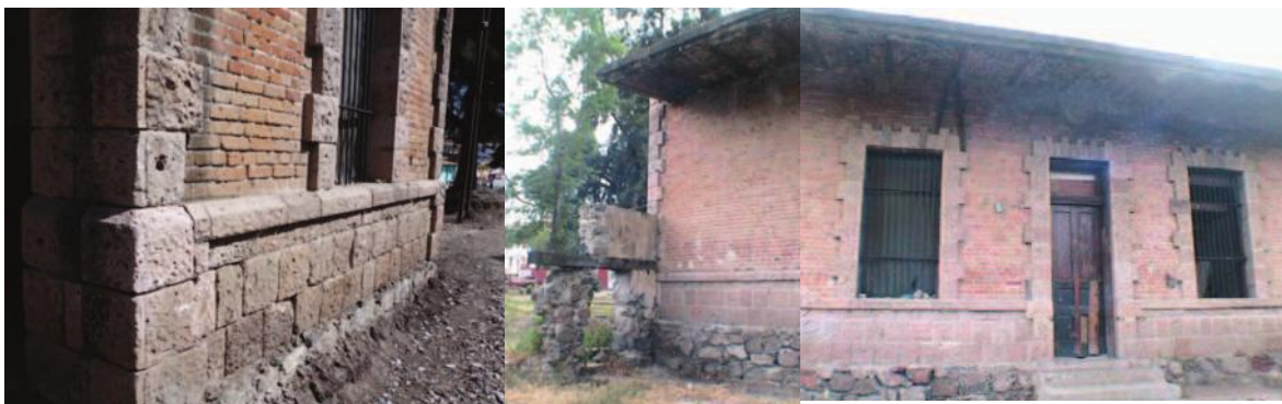
Imagen 049, 050 y 051. En las imágenes se puede apreciar el rodapié de cantería con remate de moldura y el muro de ladrillo. Fotos: AEZL.
