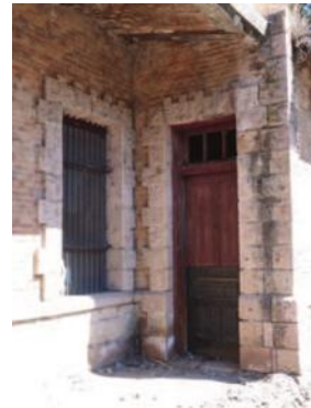
IMAGEN 066 y 067. En las imágenes se observa el enmarcamiento de cantería labrada en puertas y ventadas. Fotos: AEZL.
