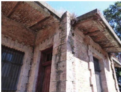
IMAGEN 068 y 069. Las imágenes muestran el enmarcamiento exterior de los muros a base de cantería labrada, presente en todas las aristas del perímetro exterior de la estación. Fotos: AEZL.
