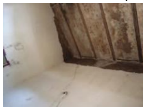
F-MAT-011 MURO DE LADRILLO
