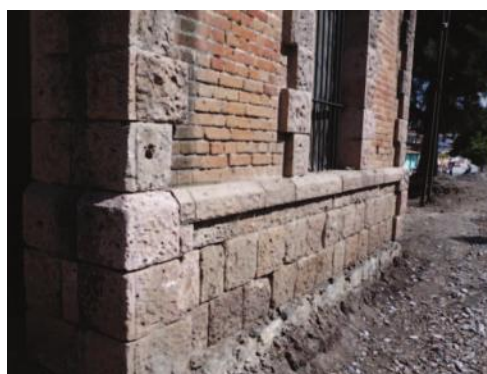
IMAGEN 064 y 065. En la imagen de la izquierda se puede observar el sistema constructivo que presentan los muros al exterior del inmueble, y en la imagen de la derecha, se aprecia el detalle del rodapié de cantería en los muros. Fotos: AEZL.
