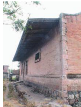
IMAGEN 068 y 069. Las imágenes muestran el enmarcamiento exterior de los muros a base de cantería labrada, presente en todas las aristas del perímetro exterior de la estación. Fotos: AEZL.
