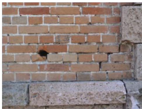
IMAGEN 117 y 118. Se puede observar las grietas, fisuras y falta de ladrillo. Foto: AEZL
