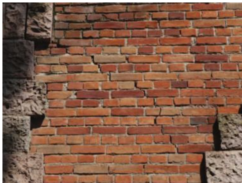
IMAGEN 115 y 116. Se puede observar las grietas, fisuras y falta de ladrillo. Foto: AEZL
