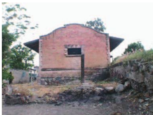
IMAGEN 107 y 108. Las imágenes muestran la presencia de humedad en todo el perímetro del edificio. Foto: AEZL.
