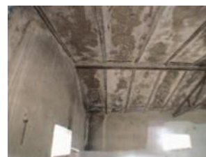
F-MAT-026 MURO DE LADRILLO
