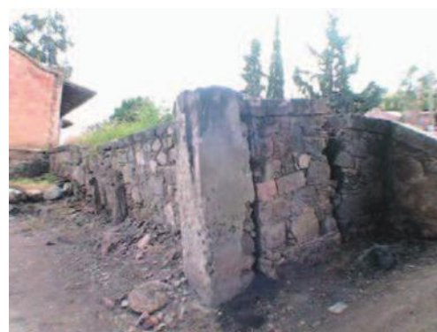
IMAGEN 139 y 140. La presencia de macroflora y Microflora es evidente en la cubierta, muros y en la zona del andén. Fotos: AEZL.
