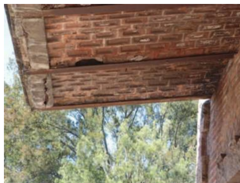
F-MAT-006 CUBIERTA TIPO ESCARZANA
