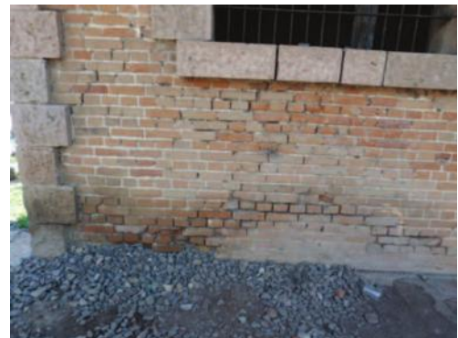
IMAGEN 115 y 116. Se puede observar las grietas, fisuras y falta de ladrillo. Foto: AEZL
