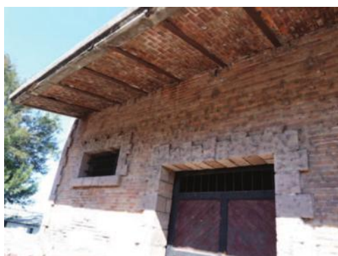
IMAGEN 062 y 063. En las imágenes se puede observar que el sistema constructivo de la cubierta está constituido por una bóveda escarzana. Fotos: AEZL.
