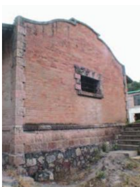
IMAGEN 064 y 065. En la imagen de la izquierda se puede observar el sistema constructivo que presentan los muros al exterior del inmueble, y en la imagen de la derecha, se aprecia el detalle del rodapié de cantería en los muros. Fotos: AEZL.
