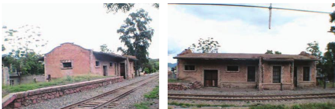
Imagen 058 y 059. Fachada norponiente lateral y fachada principal suroeste que presentan las mayores incidencias de asoleamiento en el edificio. Fotos: AEZL.
