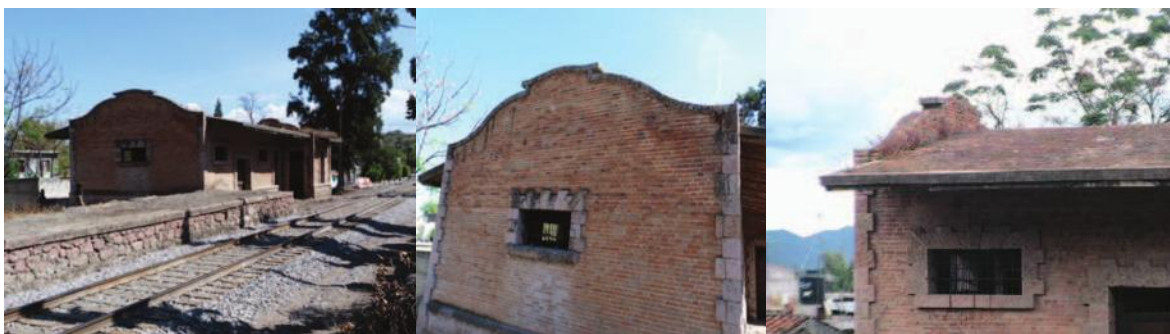
Imagen 055, 056 y 057. La primera imagen muestra el tipo de cubierta a dos aguas, y en las imágenes subsecuentes se observa el remate de los muros piñones. Fotos: AEZL.
