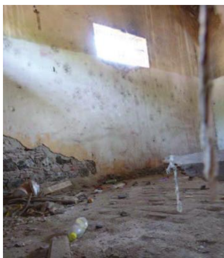
IMAGEN 119 y 120. Se puede observar las grietas y desprendimiento de aplanado en muros interiores. Foto: AEZL
