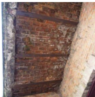
IMAGEN 141 y 142. Se observa el estado de la bóveda escarzana y del estado de los elementos que la componen. Fotos: AEZL.
