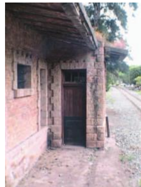
Imagen 052, 053 y 054. Se aprecia el enmarcamiento a base de cantería en puertas y ventanas. Fotos: AEZL.
