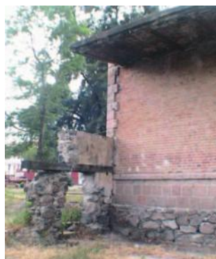
IMAGEN 107 y 108. Las imágenes muestran la presencia de humedad en todo el perímetro del edificio. Foto: AEZL.
