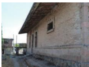
F-MAT-041 MURO DE LADRILLO
