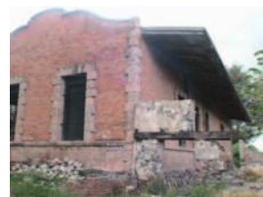
F-MAT-024 MURO DE CANTERIA
