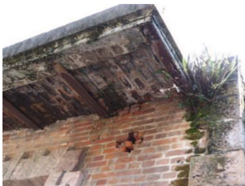
IMAGEN 117 y 118. Se puede observar las grietas, fisuras y falta de ladrillo. Foto: AEZL
