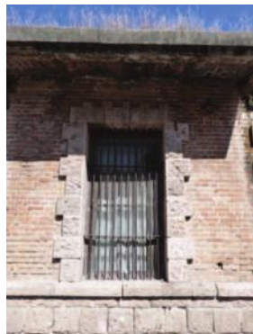
Imagen 052, 053 y 054. Se aprecia el enmarcamiento a base de cantería en puertas y ventanas. Fotos: AEZL.
