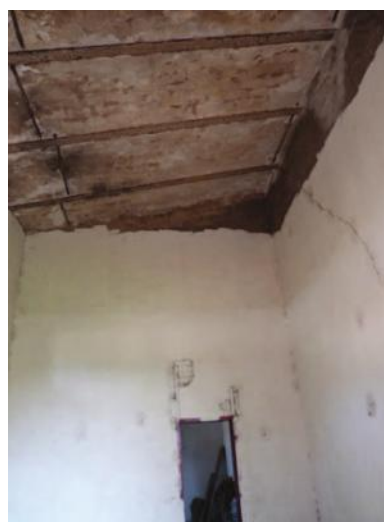
IMAGEN 119 y 120. Se puede observar las grietas y desprendimiento de aplanado en muros interiores. Foto: AEZL
