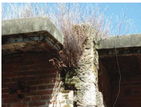
IMAGEN 139 y 140. La presencia de macroflora y Microflora es evidente en la cubierta, muros y en la zona del andén. Fotos: AEZL.
