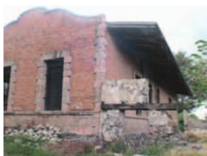
F-MAT-025 MURO DE LADRILLO
