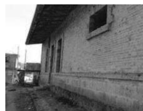
F-MAT-002 SOBRECIMIENTO TOMADA POR: AEZL. FECHA: 29/DIC/2011
