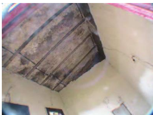
IMAGEN 125 y 126. La falta de mantenimiento y la mala calidad del mismo es notable en los muros interiores del inmueble. Fotos: AEZL.
