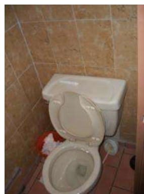
Fig. 76. Sanitario ubicado en la antesacristía. Foto: autora.
