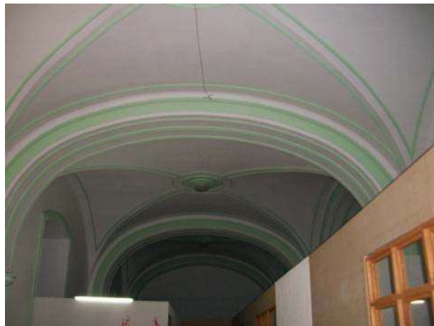
Fig. 14. De la capilla, en la que se aprecia los muros divisorios y la cubierta. Elaborado: la autora.
