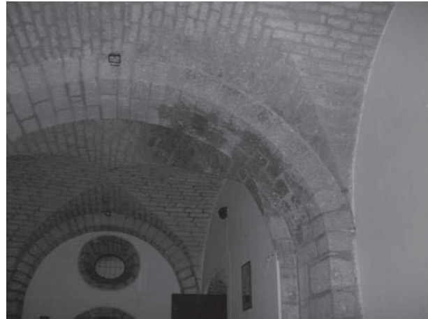
Fig. 15. Vestíbulo, imagen en donde se distinguen el tipo de muros y vanos existente y cubiertas vista hacia el muro sur del espacio. Elaborado: la autora.
