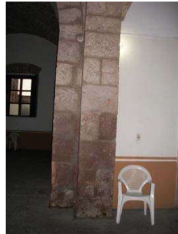
Fig. 94. Se aprecia tubería hidráulica e instalación eléctrica visibles. Foto: autora.
