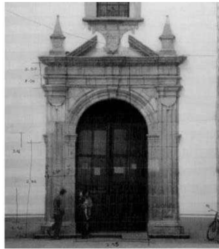
Fig. 17. Fotografía de la Fachada con mediciones. Foto: autora.
