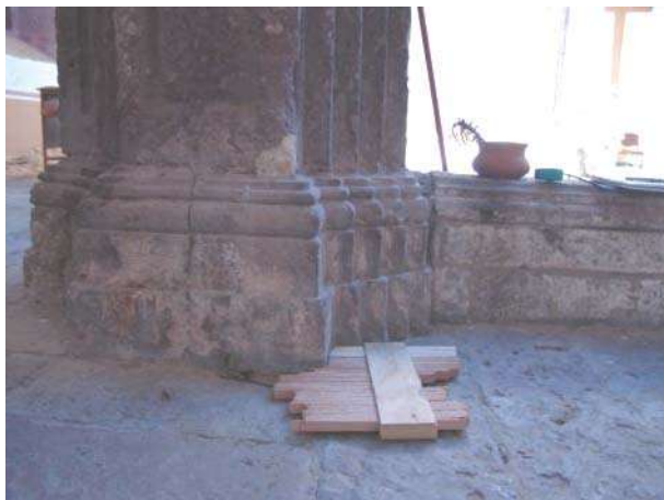
Fig. 18. Utilización de equipo especializado para la medición de molduras (peine). Elaborado: la autora.
