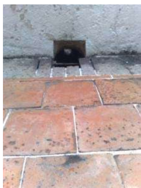
Fig.75. Bajadas de Agua de los pasillos del claustro. Foto: autora.
