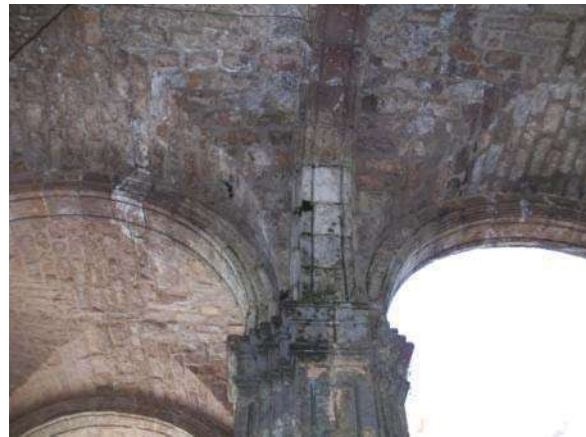
Fig. 91. Bóvedas de arista de los pasillos del claustro Foto: Yadira C. Avila Naranjo.
