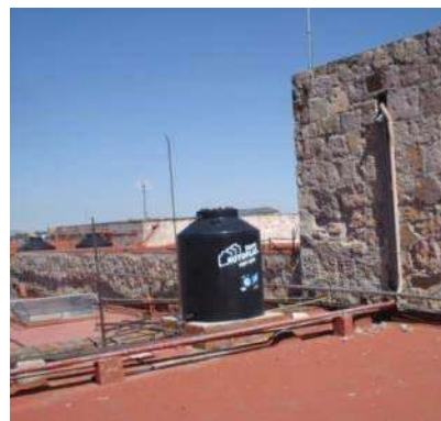
Fig.74. Tinaco ubicado en la azotea. Foto: la autora.
