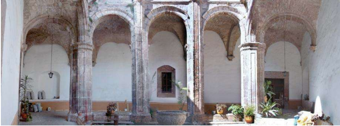
Fig. 25. Perfil Fotográfico Oriente del Claustro en el Exconvento del Carmen. . Foto: la autora.
