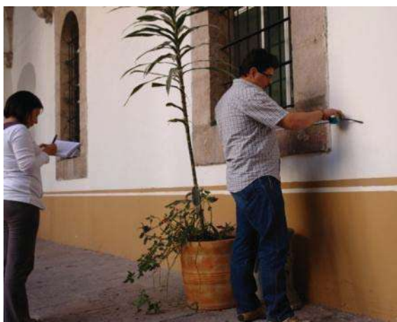
Fig. 20. Medición con flexómetro para levantamiento de detalles. Foto: Yadira C. Avila Naranjo.
