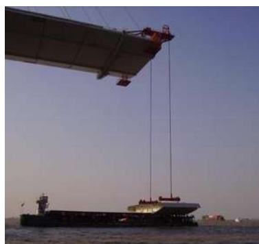
Figura 2.3.j Levantamiento de un segmento de tablero (Tomada de http://www.dormanlongtechnology.com/images/SutongDeckLift.jpg ).
