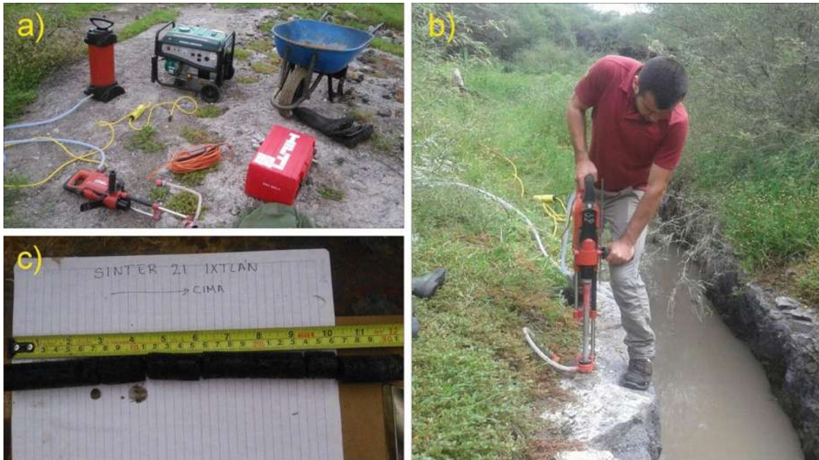
Figura 27. Obtención de núcleos de sínter; a) equipo utilizado para la obtención de los núcleos, el cual incluye generador de electricidad, cables de corriente, una bomba de agua, y el taladro; b) momento de la perforación para obtener el núcleo; c) núcleo de sínter obtenido.
