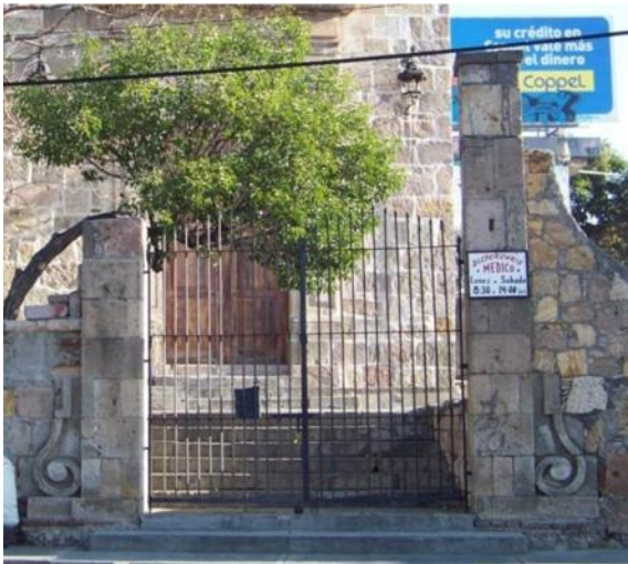
Fig. 1 Acceso al conjunto con pilastras incompletas, Fuente: fotografía tomada por: Enrique Ruiz Becerril
