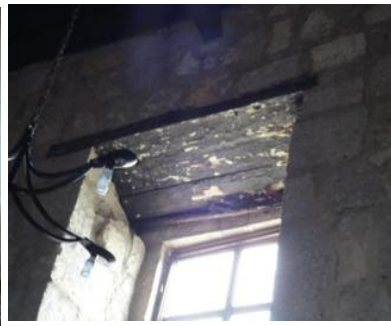
Fig. 8 Capialzado en madera Fuente: fotografía tomada por Enrique Ruiz Becerril.
