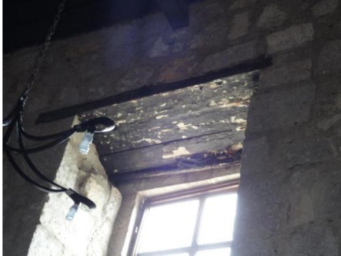
Fig. 25 Capialzado de madera en las ventanas de la capilla. fuente: Enrique Ruiz Becerril.
