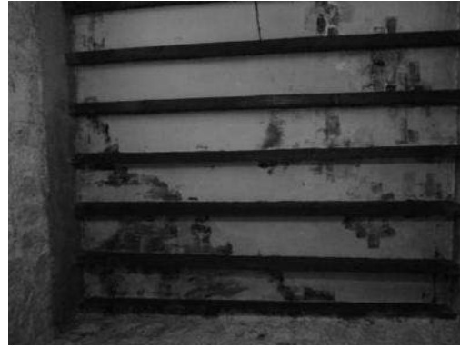
Fig. 27 Cubierta de la sacristía fuente: Enrique Ruiz Becerril.
