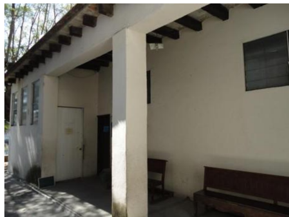
Fig. 13 Vista exterior desde el portal del dispensario médico, Fuente: fotografía tomada por Enrique Ruiz Becerril.
