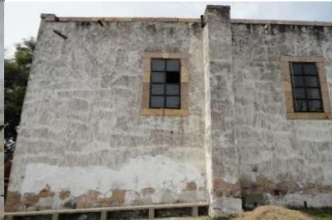
Fig. 7 Pérdida de aplanado en muro exterior oriente, fuente: Enrique Ruiz Becerril.
