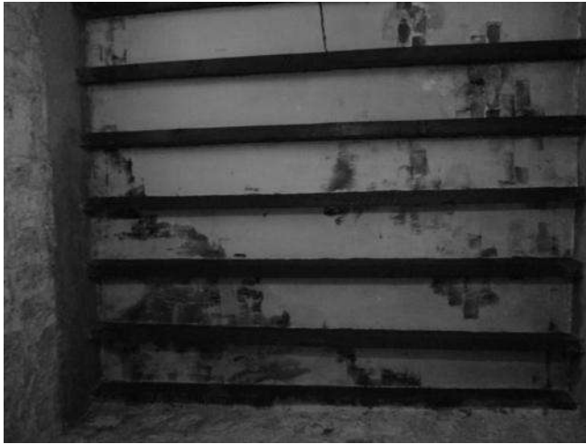
Fig. 11 Cubierta de losa de concreto sobre viguería de madera en la Sacristía, Fuente: fotografía tomada por Enrique Ruiz Becerril.
