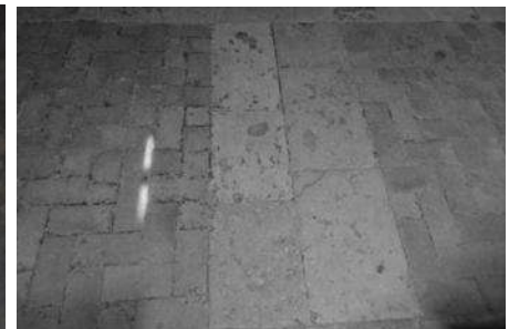
Fig. 9 Piso de la Capilla con Baldosas de Barro y de cantería, Fuente: fotografía tomada por Enrique Ruiz Becerril.
