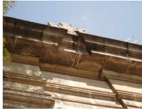
Fig. 23 Acercamiento a la cornisa de la portada, fuente: Enrique Ruiz Becerril.
