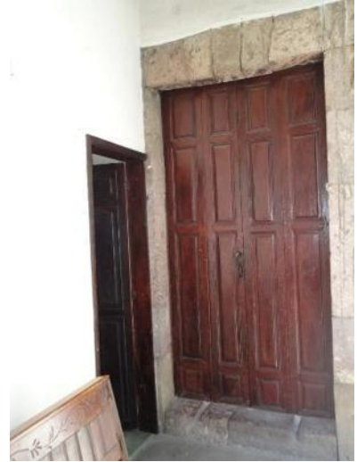
Fig. 19 Vista del acceso a la sacristía con la clave deslizada, fuente: Enrique Ruiz Becerril.
