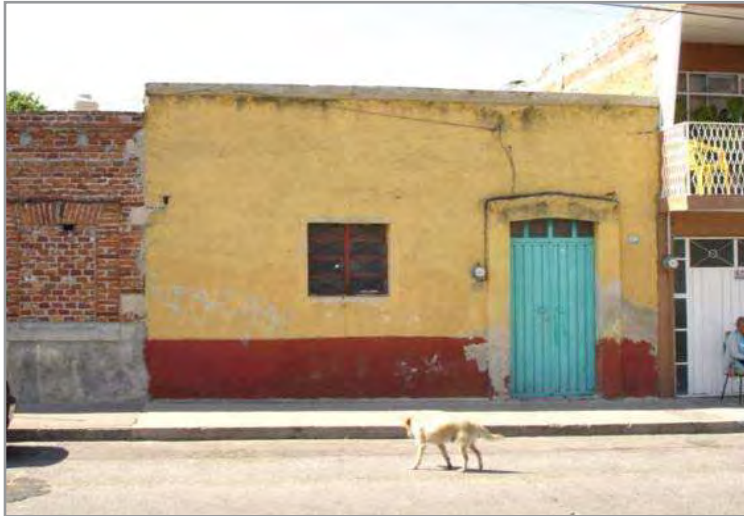
Foto 4 .- Casa en la calle Alfareros de Capula de la colonia Vasco de Quiroga, con muros de abobe, marco en puerta de y cornisa en base a mortero de cal. Foto autor. Fabricio Espinosa Ortiz
