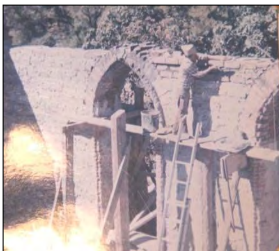
Figura 65. Re estructuración de muro de adobe, reposición de viguería y tejamanil en el templo del Señor del Agua, diciembre de 1986,1988.
