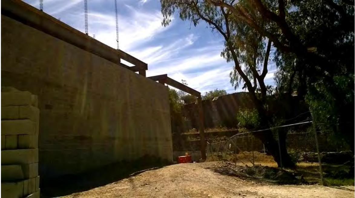
Figura 47. Construcción en proceso de gasolinera sobre el antiguo camino a Guanajuato, contiguo a la ex hacienda de Dolores en Marfil.
