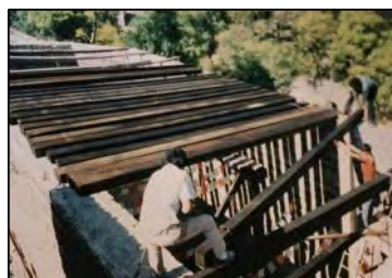
Figura 65. Re estructuración de muro de adobe, reposición de viguería y tejamanil en el templo del Señor del Agua, diciembre de 1986,1988.
