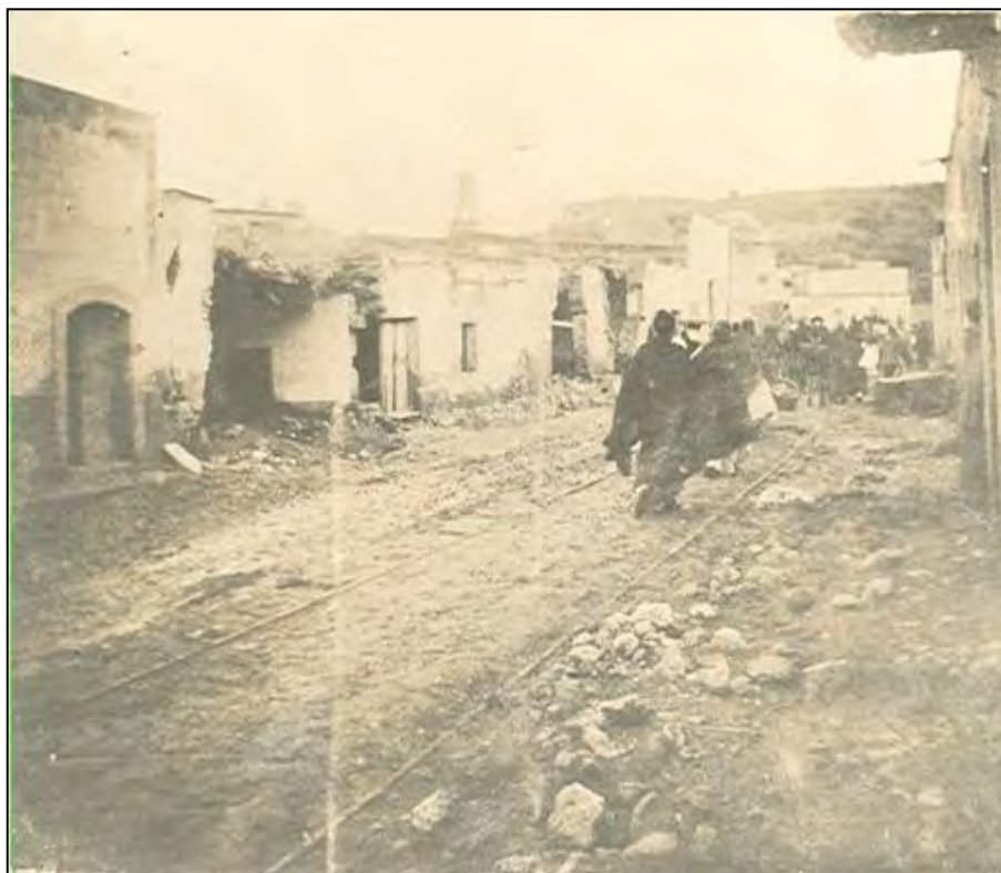
Figura 6. Calle de abajo, después de la inundación.
