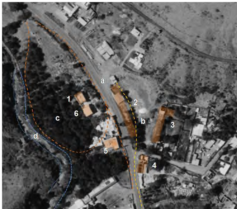
Figura 4. Ubicación de la estación de Tenerías marcando las permanencias de algunas de sus estructuras para el año de 1970.
