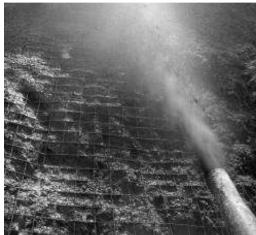
Figura 6.56. Empleo de concreto lanzado armado con malla electro soldada.
