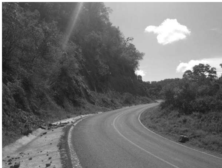
Figura 6.23. Topografía del talud “El Alamo” con algunos fragmentos de roca en la cuneta.
