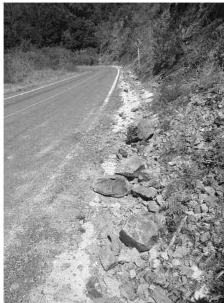
Figura 6.22. Cunetas del talud “El Alamo” con material producto de talud.
