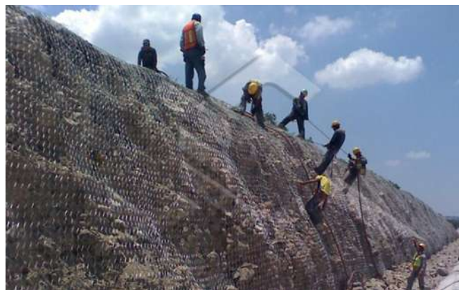
Figura 6.55. Colocación y empleo de malla Triple Torsión.
