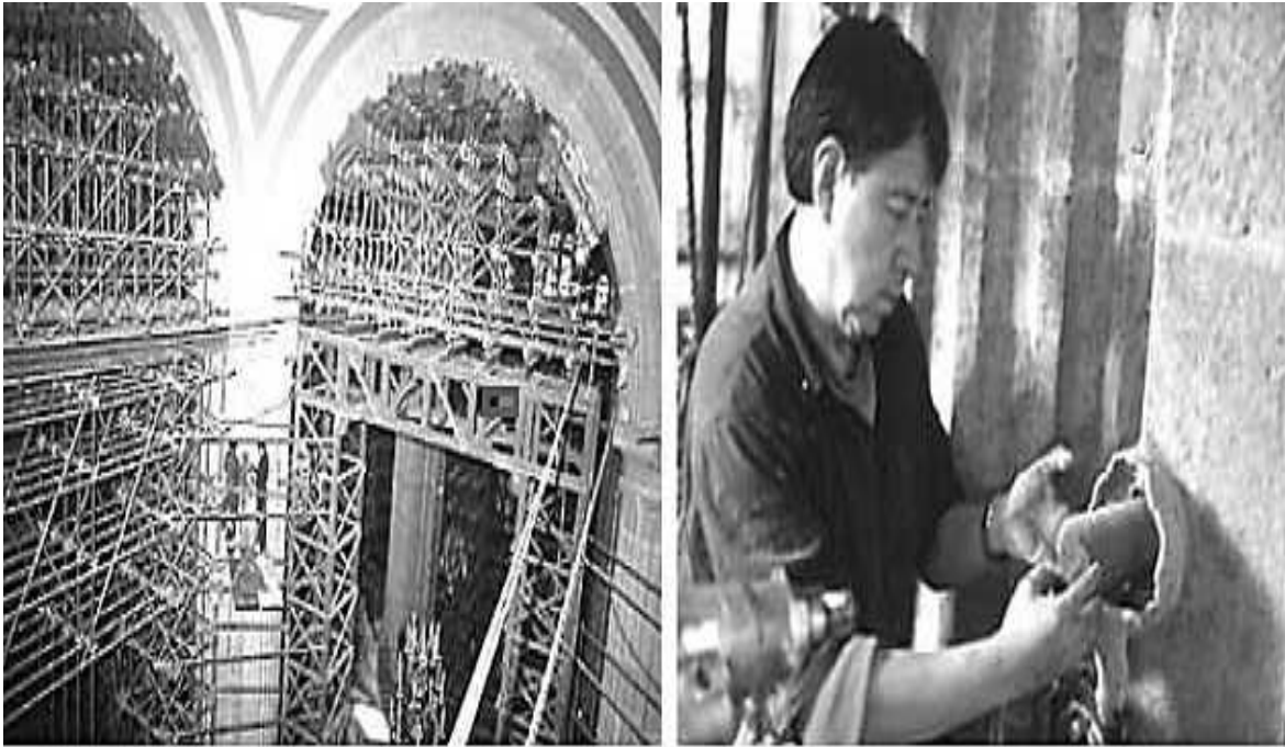
Figura 3.51. Extracción de núcleos de los pilares de la Catedral Metropolitana. (Martínez, 2017)
