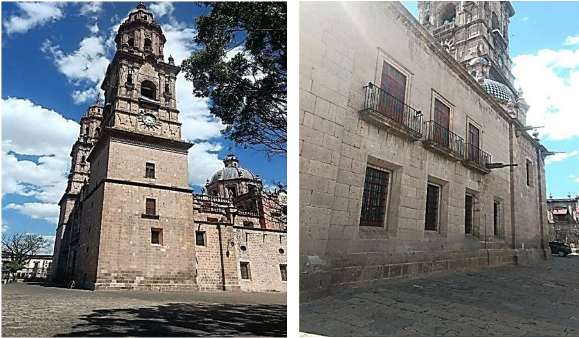
Figura 2.21. Torre poniente (Izquierda) y Sacristía del Sagrario (Derecha) de la catedral de Morelia. Imagen tomada por: Eduardo Reyes Negrete.
