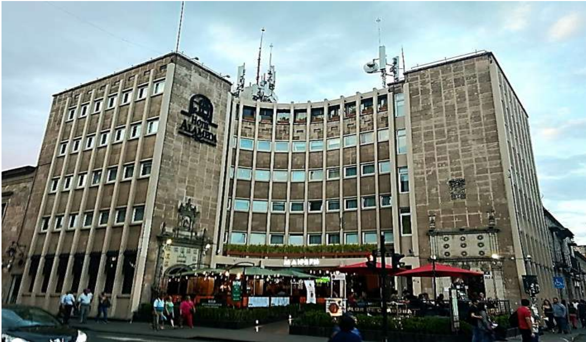
Figura 2.31. Fachada principal del Hotel Alameda. Imagen tomada por: Eduardo Reyes Negrete.
