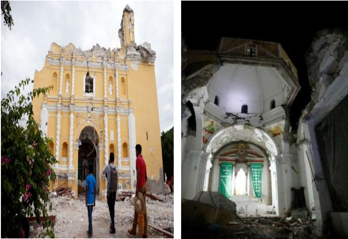
Figura 7.220. Colapso del Templo de Santiago, Atzala, Puebla. (3)
