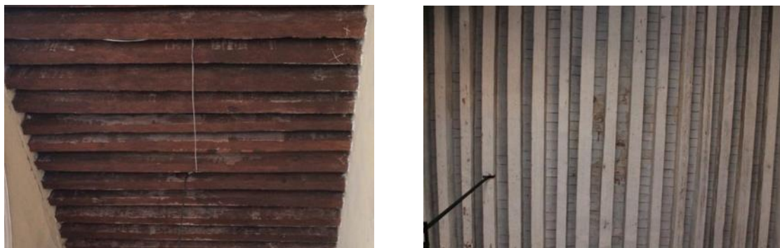
Fig. 89 Viguería en entrepiso y cubierta 114
