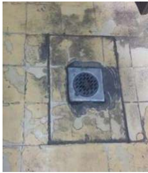
Fig. 98 Registro con coladera en sanitarios 119
