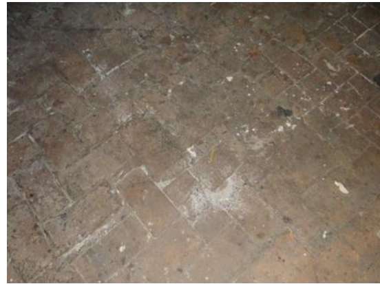
Fig. 84 Pisos de barro rojo 107
