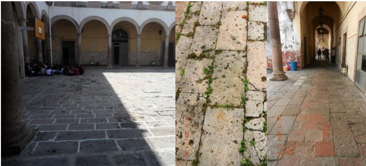
Fig. 86 Piso de baldosa de cantera 109
