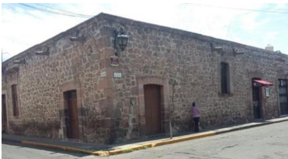
Fig. 32 Construcción de mampostería irregular con cadena de ángulo 59
