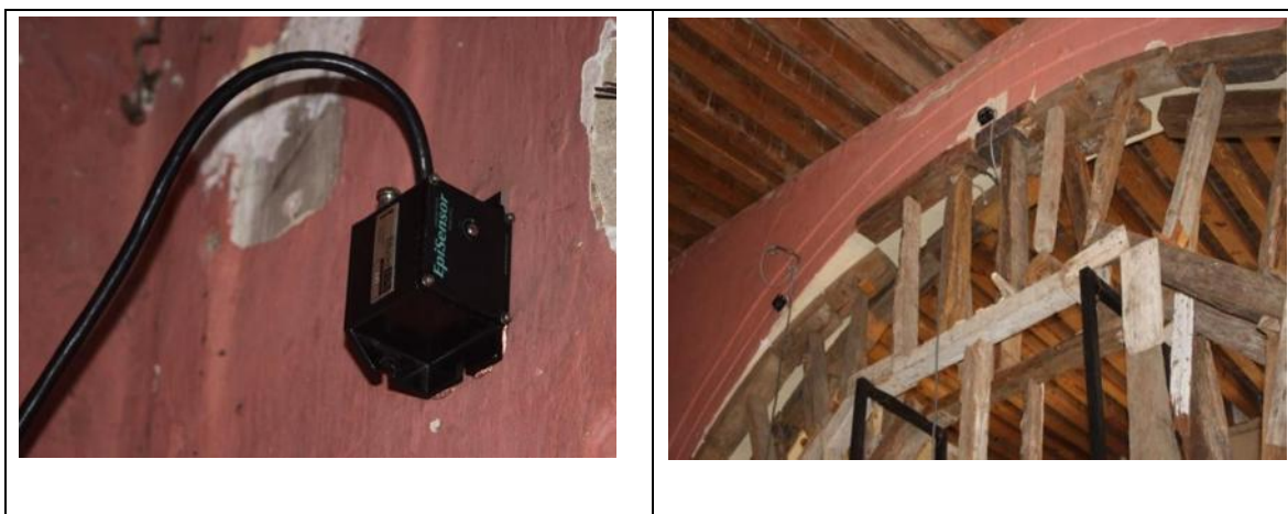
Fig. 137 Sensores colocados en clave, riñones y arranque del arco 148
