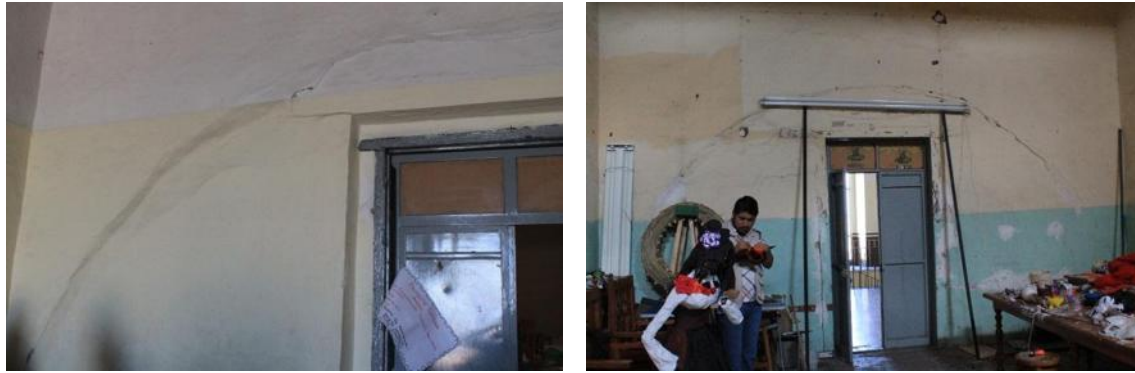
Fig. 82 Arco de descarga. Segundo nivel 105
