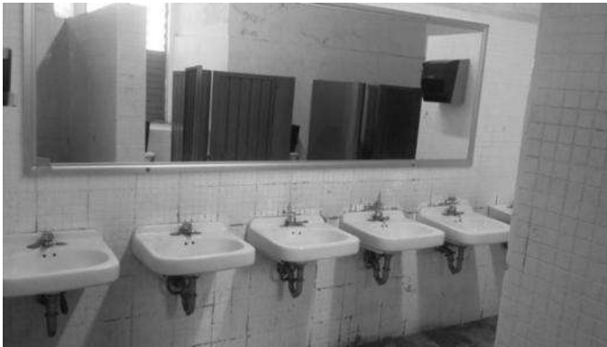
Fig. 96 Muebles sanitarios con su sistema de desagüe 117
