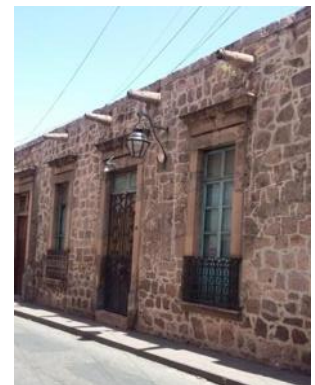
Fig. 29 Fachada sin aplanar 60
