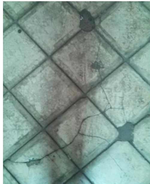
Fig. 85 Pisos de cemento requemado 108
