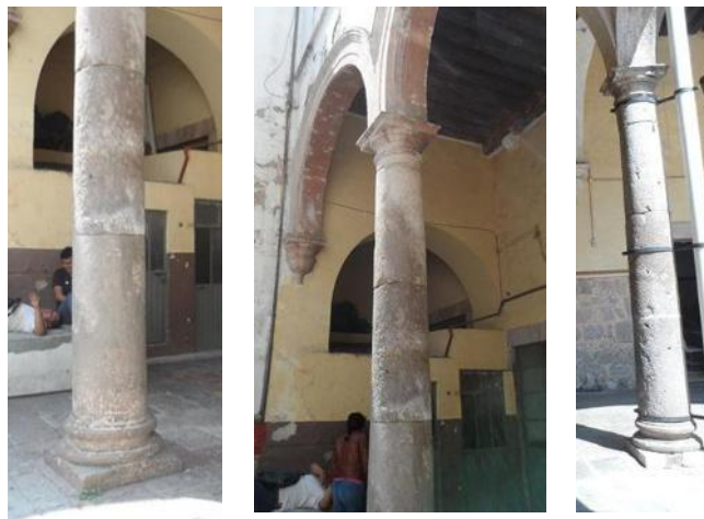
Fig. 88 Columnas circulares que sostienen la arquería de los patios 112
