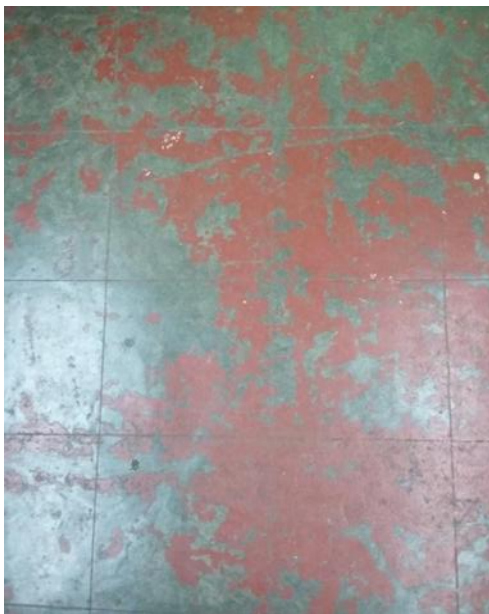
Fig. 85 Pisos de cemento requemado 108
