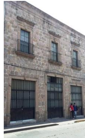
Fig. 23 Construcción de dos niveles 60
