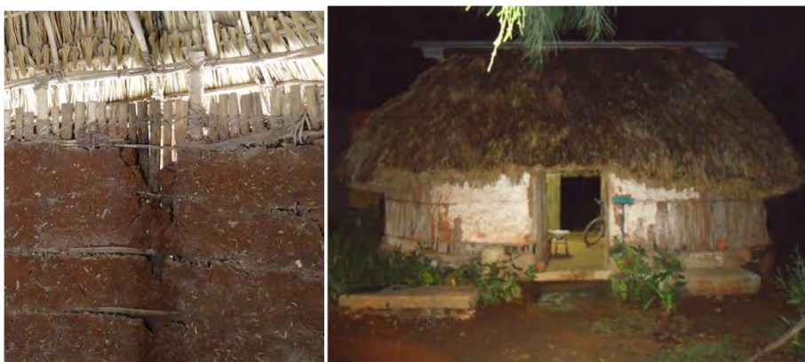
Figura 4. Vivienda realizada con la técnica de bajareque. Ubicada en la zona maya. Fotos: A. Cuéllar
