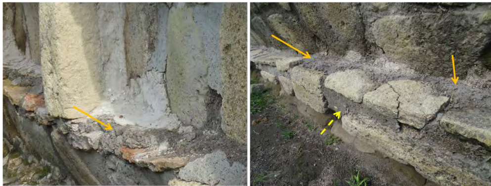
Figura 66. Imagen donde se observa el uso de los morteros de nivelación (señalado con la flecha amarilla) en donde la piedra se encuentra con mayores irregularidades y mediante el uso del mortero se empareja el área para colocar posteriormente el aplanado. La flecha punteada indica un mortero aplicado recientemente durante los trabajos de excavación y consolidación. Fotos: A. Cuéllar
