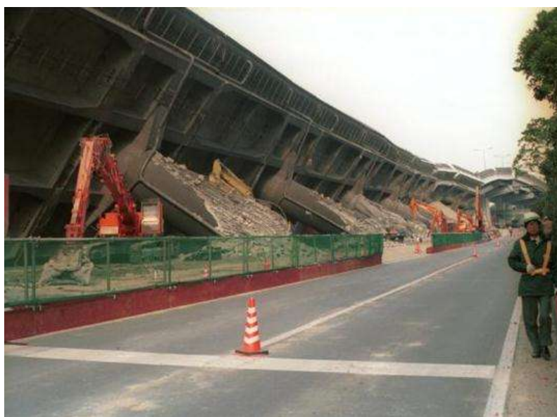
Figura 2.9 Viaducto de Higashi-Nada colapsado durante el terremoto de Hyogoken-Nanbu (Kobe) en 1995 (Foto: M. Yoshimine 2001).
