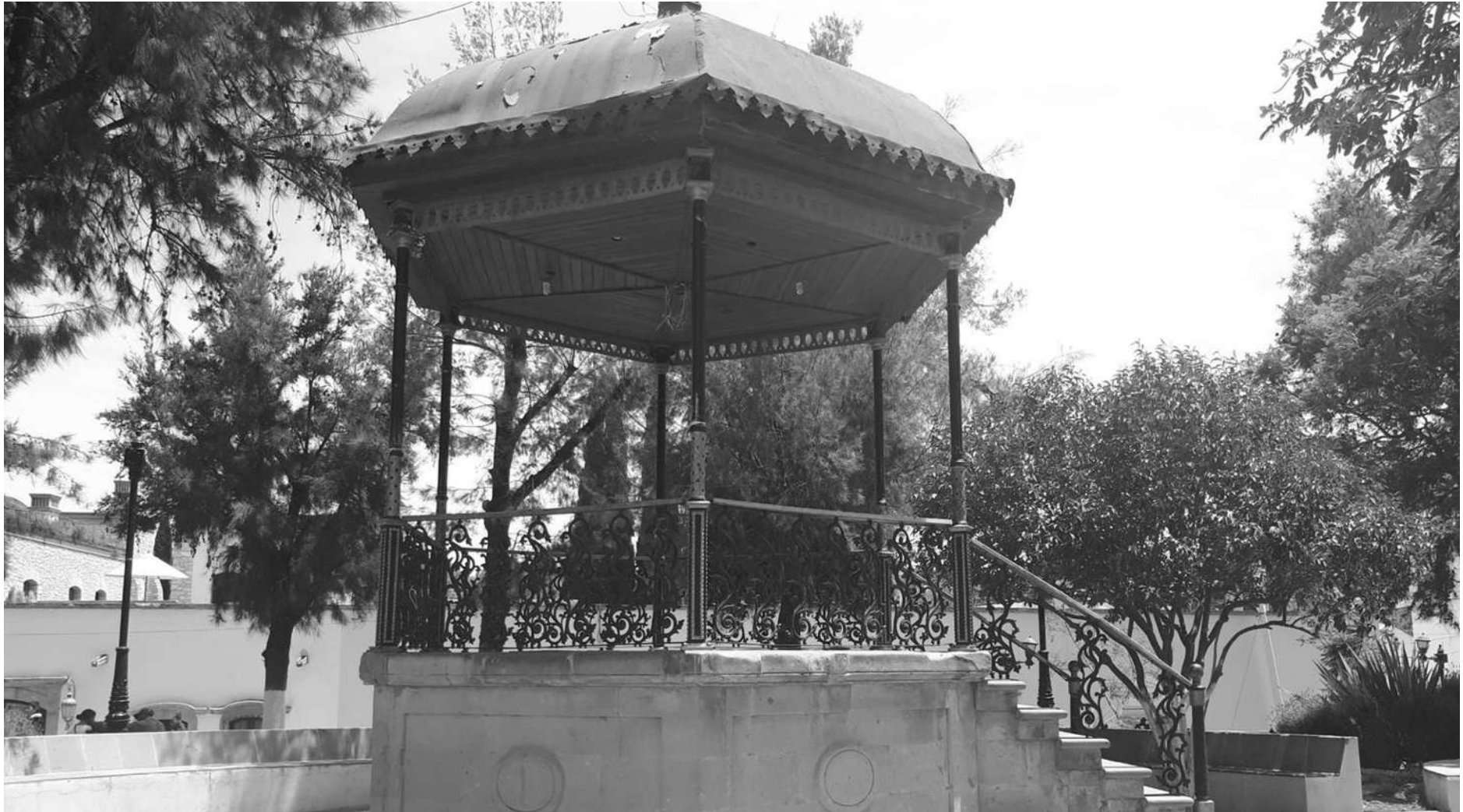
Imagen 11. Quiosco principal de Mineral de Pozos
