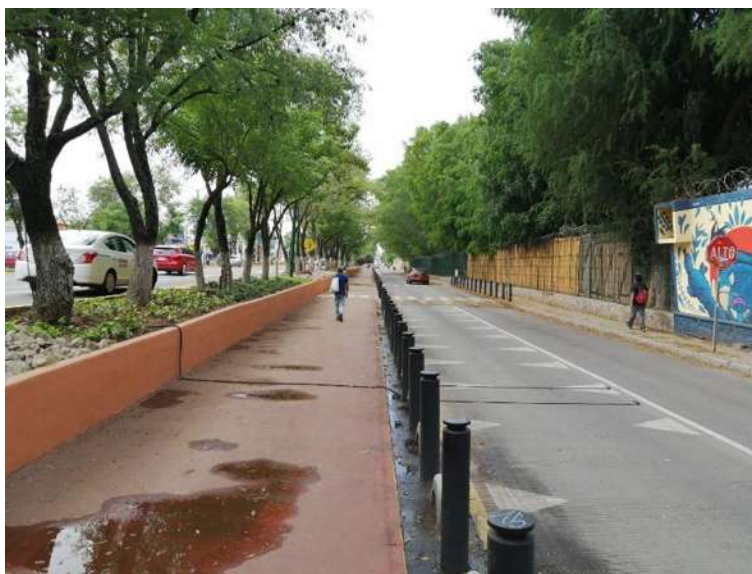
Figura 68. Cruce peatonal a nivel de calle sentido norte en la zona escolar 04
