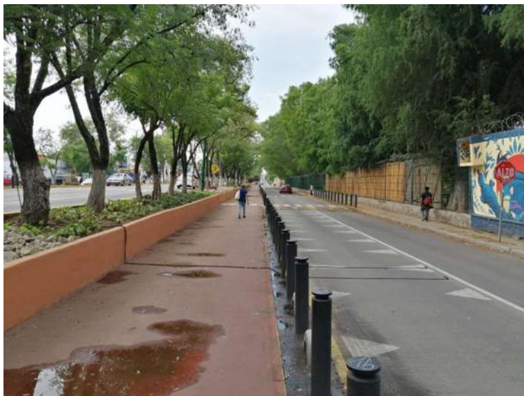
Figura 80. Imagen de instalación de equipo terminado
