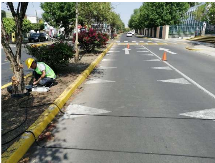
Figura 64. Cruce peatonal a nivel de calle sentido poniente en la zona escolar 02
