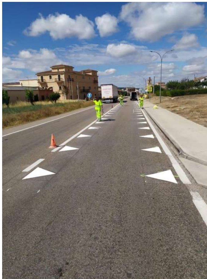
Figura 41. Marca de dientes de dragón, instalado por Ministerios de transporte, Movilidad y A. Urbana. Tomada de https://neomotor.epe.es/conduccion/dientes-de-dragon-que-significa-esta-nueva-senalizacion-de-la-dgt-XJNM8527
