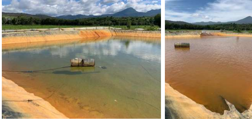
Figura 28 Laguna de captación de agua de lluvia
