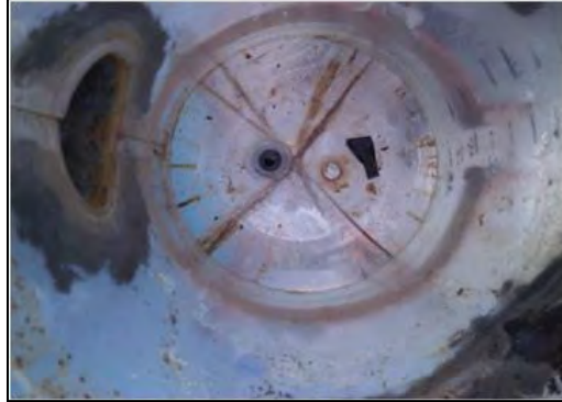
Figura 4.10 Daños internos en el reactor #1, después del uso del suero de leche.
