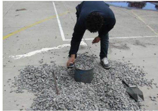
Ilustración 24 enrasado de la grava. Fuente: Elaboración propia.
