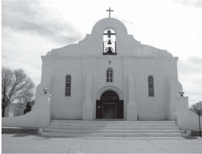
Fig. 3.23.-Aspecto del templo del presidio de San Eleazario en la actualidad. Fotografía del autor, de 2009.
