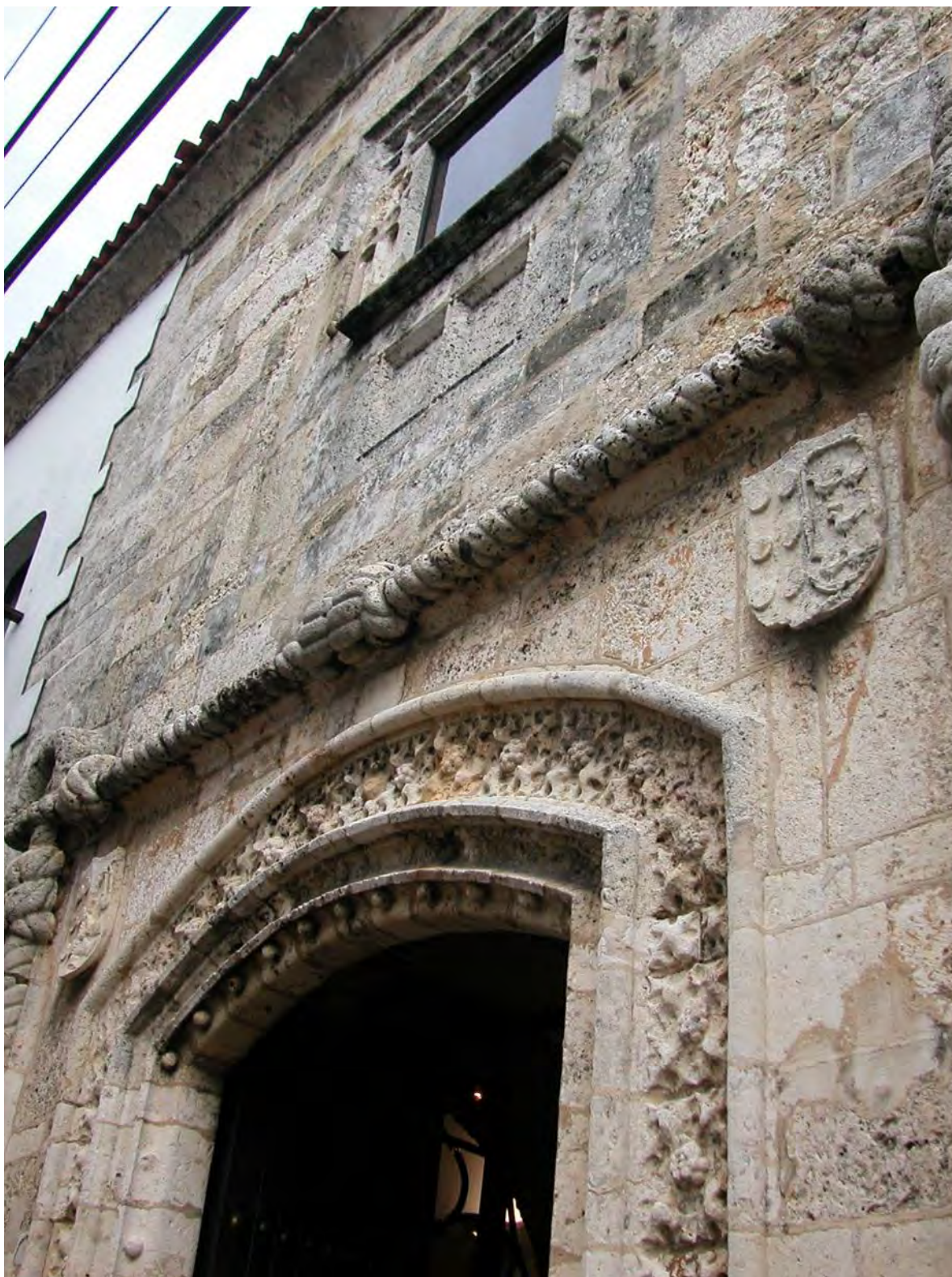
Figura 4.108. Detalle de la fachada de la Casa del Cordón. Foto: César de la Cruz.
