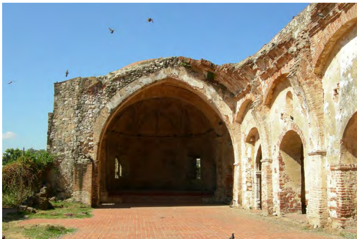
Figura 4.43. Ruinas de la Capilla de la Tercera Orden, de Convento e Iglesia de San Francisco. Foto: Jorge Marte.
