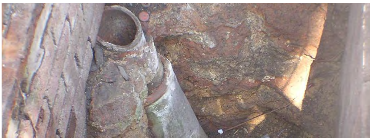
Figura 4.149. Restos de las Tomas de Agua del Acueducto de Liendo. Foto: Jorge Marte.
