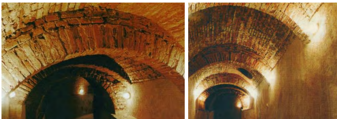
Figura 4.151. Fotografías de las Alcantarillas Coloniales de Santo Domingo. Fotos: Revista Arquitecto No.33
