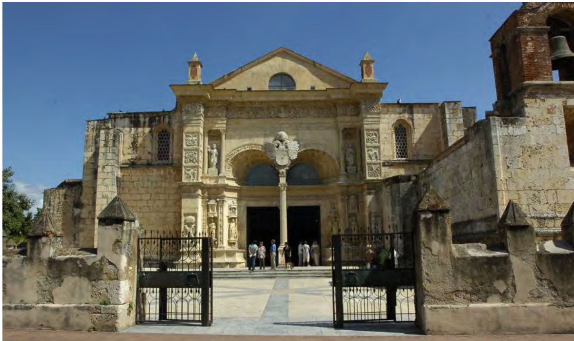
Figura 4.53. Fachada oeste de la Catedral de Santo Domingo. Foto: César de la Cruz.
