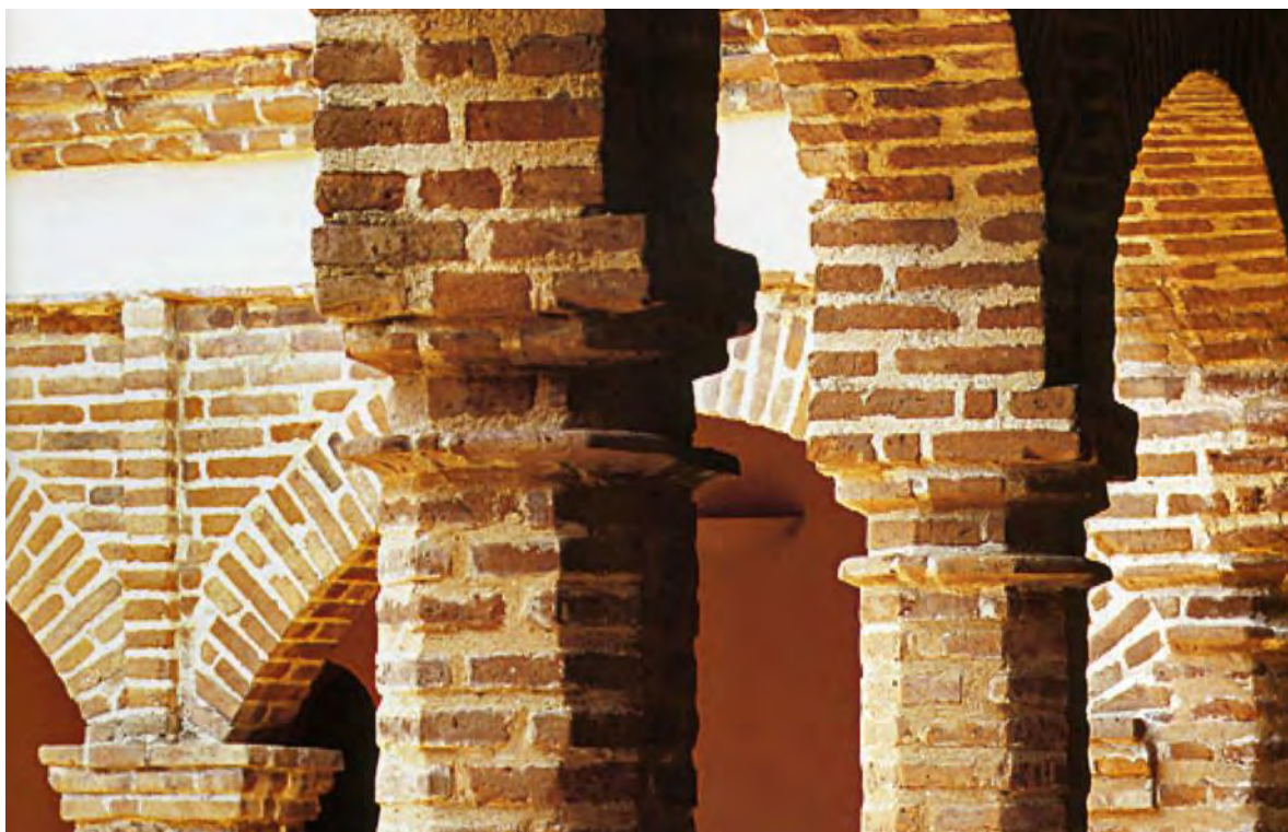
Figura 4.168. Arcada de ladrillos en el patio interior de la casa de los Dávila. Fotos tomadas de Julio Portillo, Sofitel Nicolás de Ovando, Santo Domingo, Caracas , 2006
