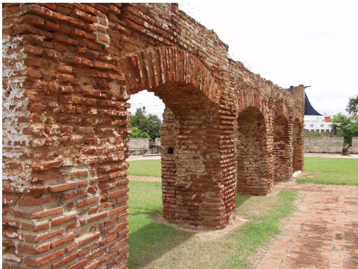
Figura 4.113. Restos del Fuerte de Santiago en la Fortaleza de Santo Domingo. Foto: José Mejía.
