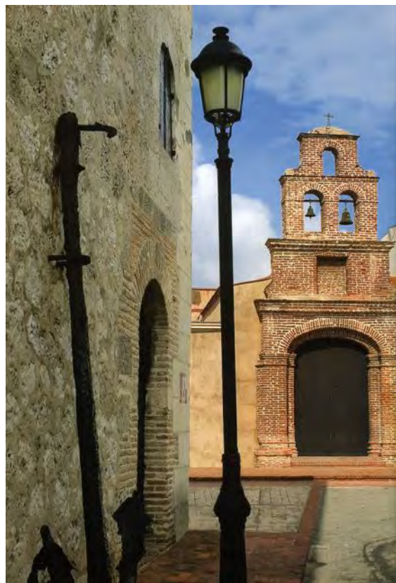
Figura 4.167. Portal de ladrillos en la fachada de la Capilla de Ntra. Sra. de los Remedios.
