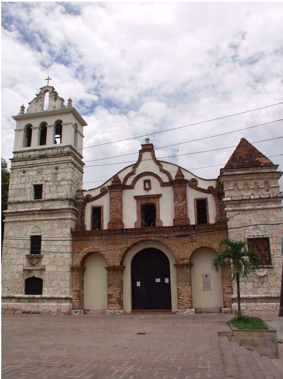
Figura 4.69. Fachada principal de la Iglesia de Santa Bárbara. Foto: José Mejía.
