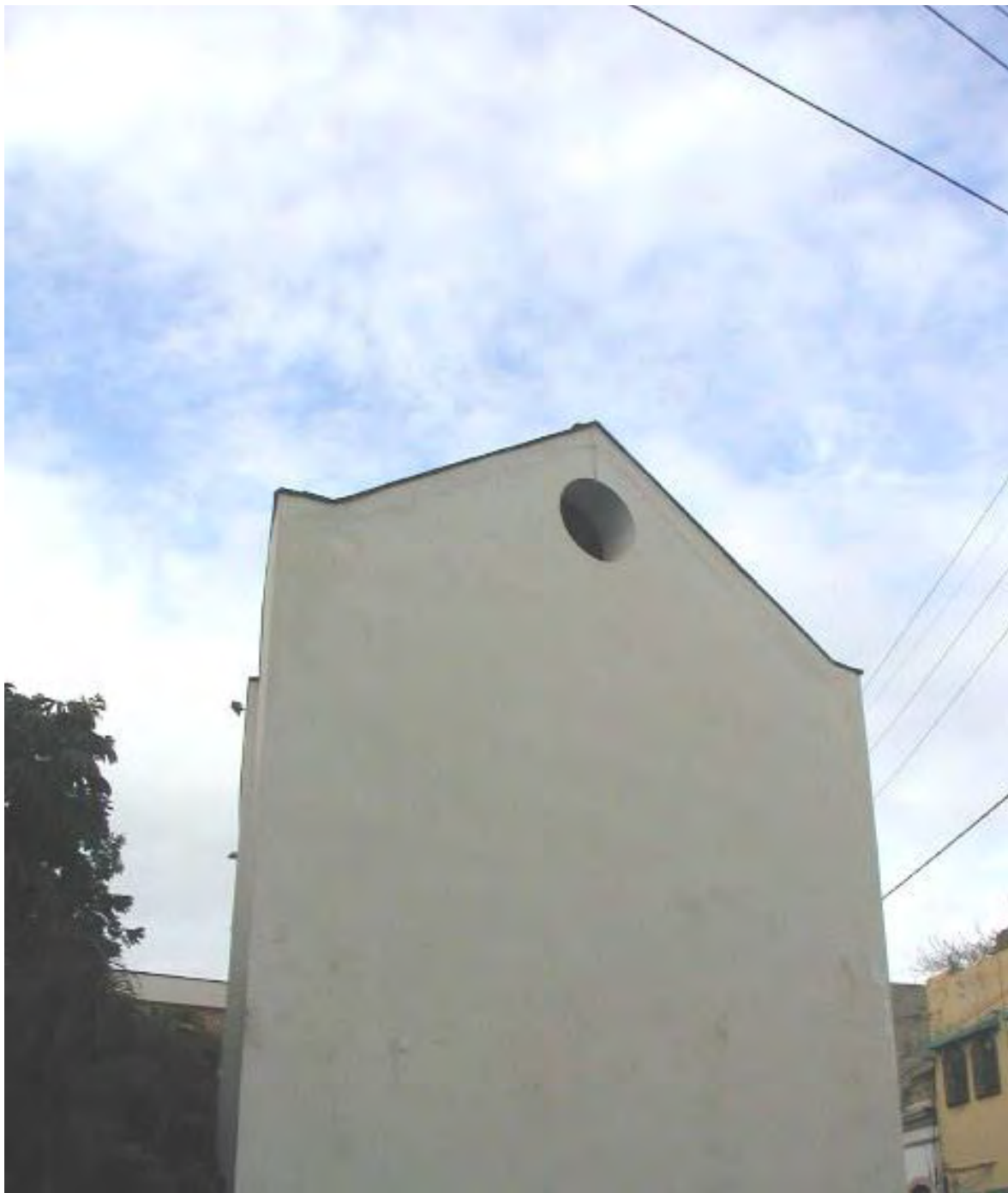
Figura 4.89. Fachada sur de la capilla del antiguo Colegio de Gorjón, actual sede del Centro Cultural de España.
