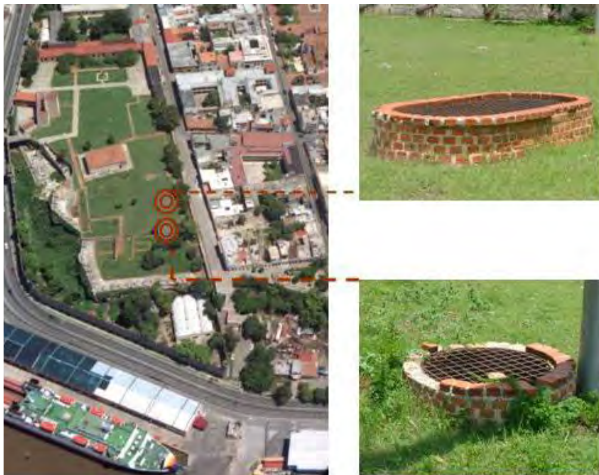
Figura 4.135. Pozos en la Fortaleza de Santo Domingo. Fotos: Linda Roca.
