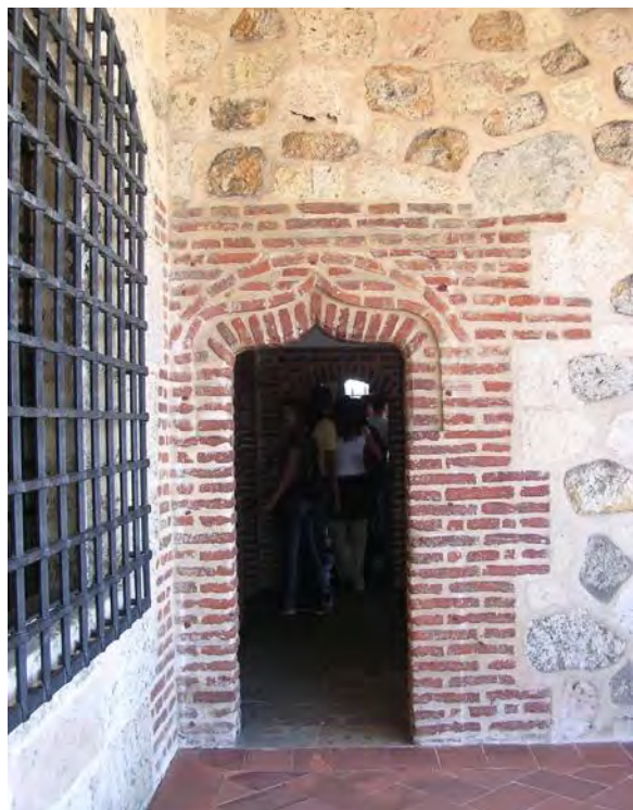
Figura 4.161. Arco conopial de ladrillo en el Alcázar de Diego Colón. Foto: Linda Roca.
