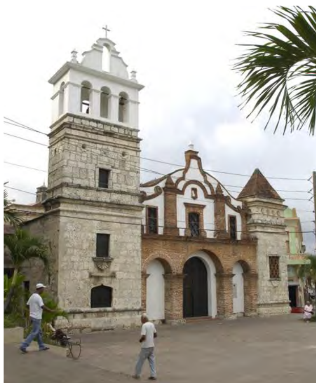
Figura 4.32. Fachada Iglesia de Santa Barbara. Foto: José Mejía.
