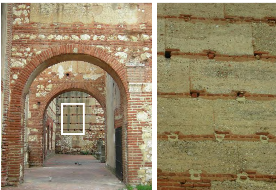
Figura 4.157. Imágenes mostrando el uso de la tapia para la construcción de muros en las ruinas del hospital de San Nicolaás de Bari. Fotos: Linda Roca.
