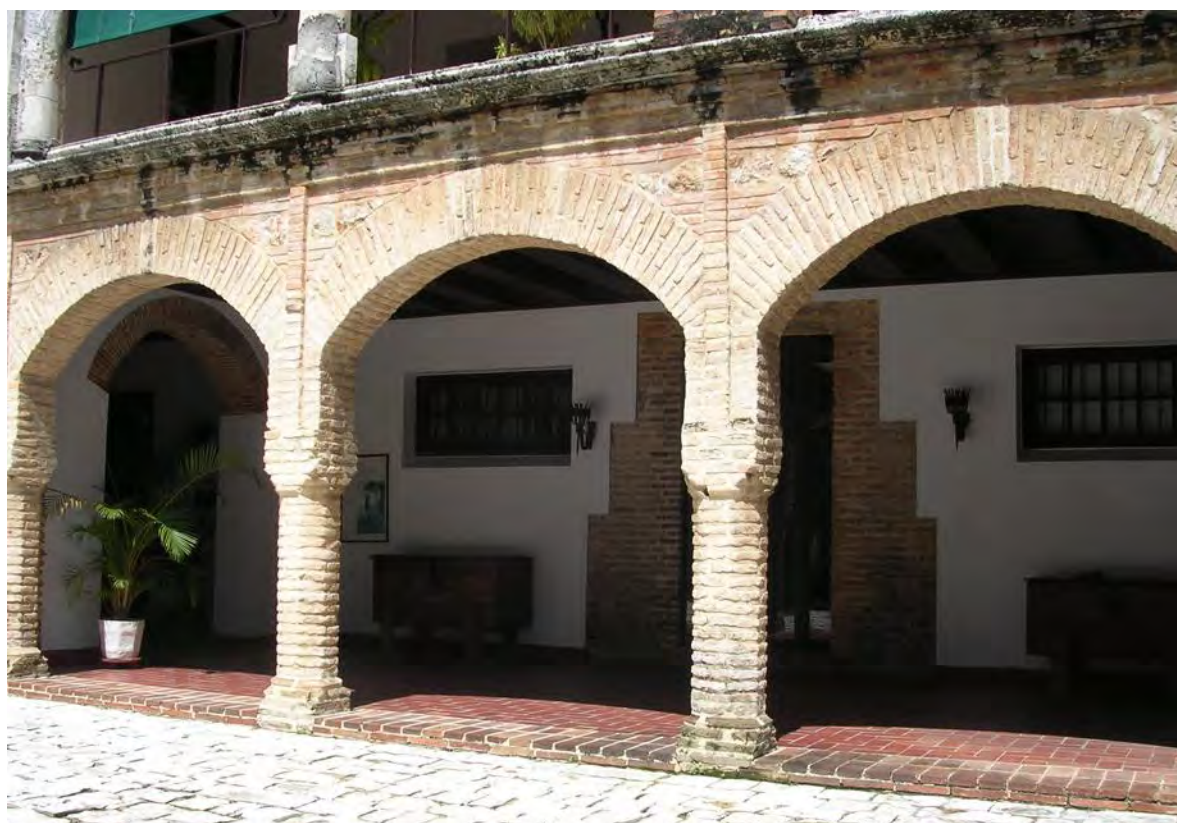
Figura 4.163. Arcada de ladrillos (patio de la Casa del Sacramento actual sede del Arzobispado de Santo Domingo). Foto: Linda Roca.
