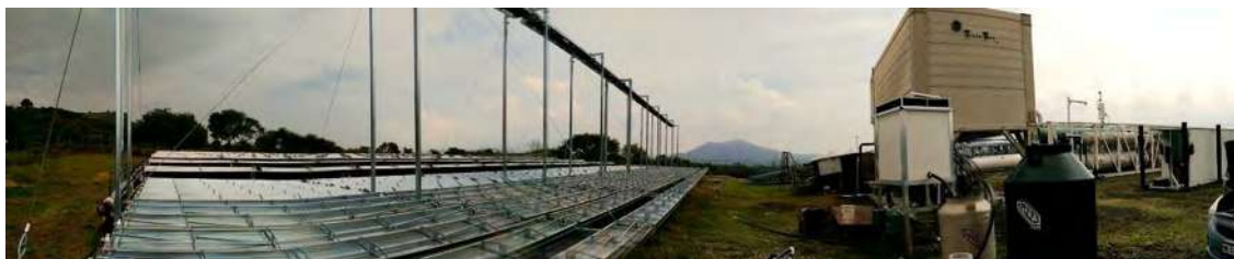
Figura 21. Planta de ciclo binario geotérmica-solar en Simirao (Zinapécuaro, Mich).
