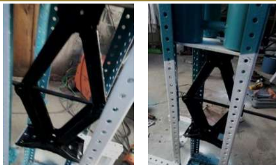
Figura 4.23. Colocación del eje y el gato mecánico
