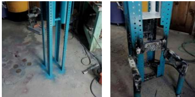
Figura 4.19. Construcción de la base
