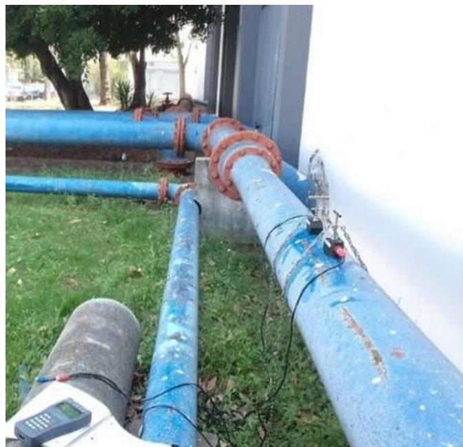
Figura 5.3: Medición de caudal disponible en laboratorio
