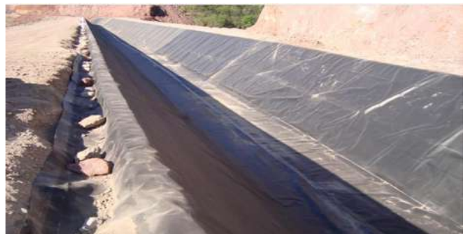
Figura 2 Canal de suministro de agua
