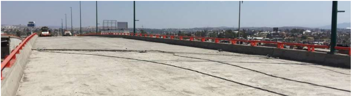
3.9. Mediciones en el puente El Pedregal el día 24/02/2015.
