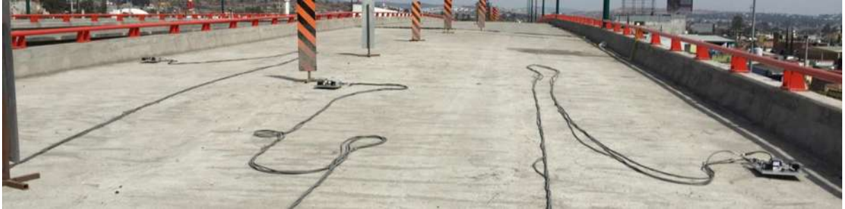
3.8. Mediciones en el puente El Pedregal el día 12/01/2015.
