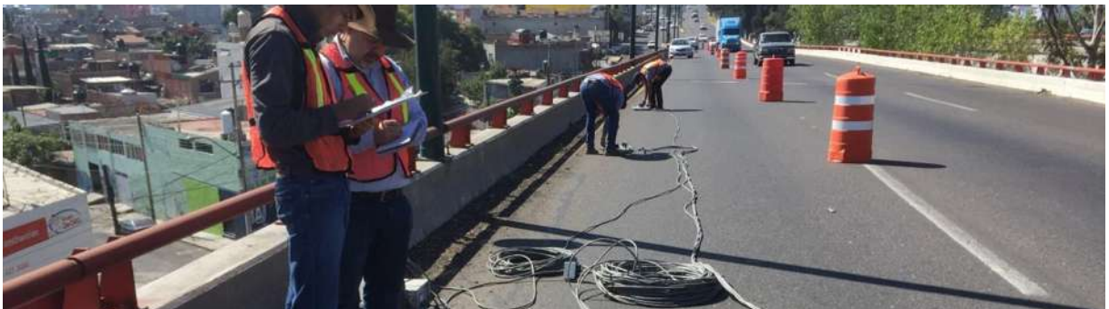
3.10. Mediciones en el puente El Pedregal el día 30/11/2015.
