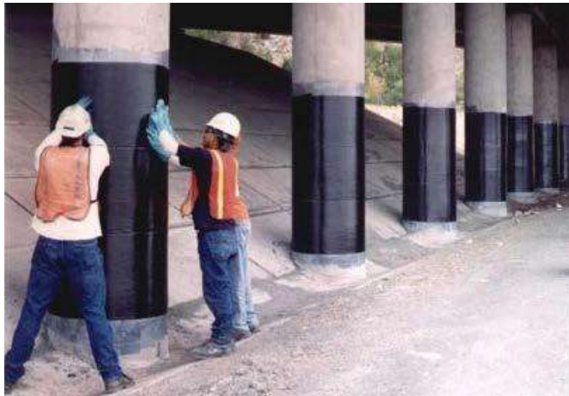
Figura 2.8 Colocación de fibras de carbono para confinamiento en las columnas
