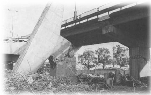
Figura 1.9 Falla por flexo compresión en la columna, sismo Kobe, 1995 (Tomada de Priestley et al., 1996)
