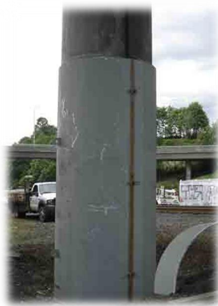
Figura 1.16 Rehabilitación de la columna, con revestimiento de acero. (Tomada de http://www.wsdot.wa.gov/Projects/15/SSeattleSeismic/Photos )
