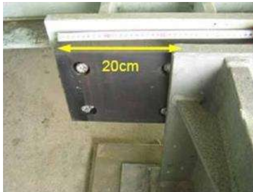
Figura 2.14 Desplazamiento permanente de un apoyo
