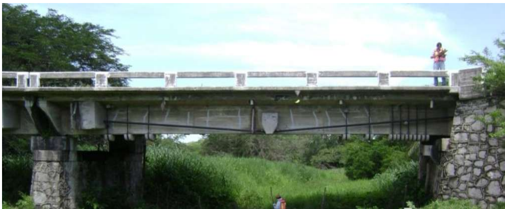
Figura 2.10 Presfuerzo externo de un puente
