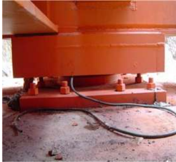
Figura 2.20 Sistema de aislamiento deslizante tipo multirrotacional
