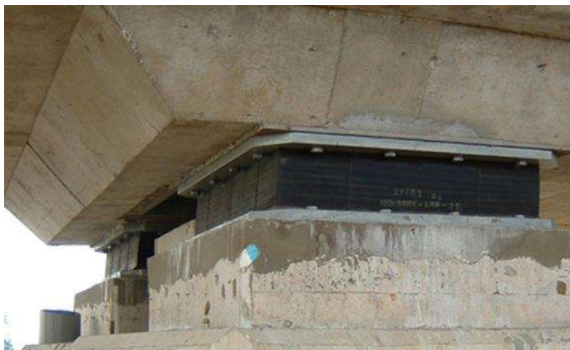
Figura 1.19 Disipadores de energía de hule y acero con corazón de plomo (Tomada de http://www.tecnoav.cl/wp-content/uploads/2012/01/img1_large_20110921133951.jpg )
