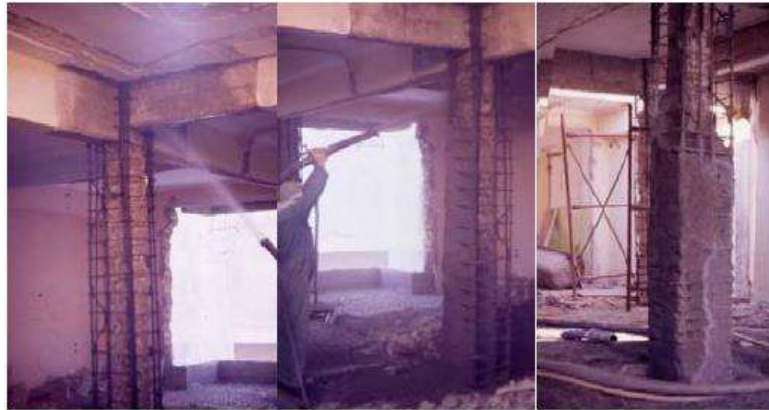
Figura 2.5 Revestimiento de la columna por el método de concreto lanzado.
