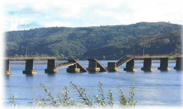
Figura 1.4 Falla debido a la licuación del suelo (tomada de http://www.scielo.org.ve/scielo.php?pid=S0798-40652012000200007&script=sci_arttext )
