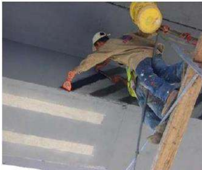
Figura 2.12 Aplicación de fibras carbón para el refuerzo de flexión y cortante
