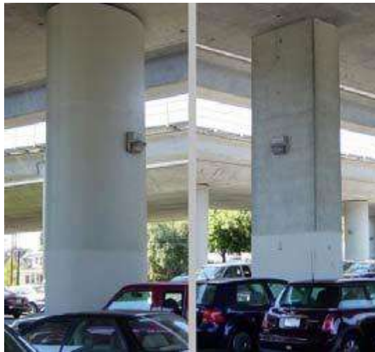
Figura 2.6 Columna rehabilitada con la técnica de encamisado metálico.
