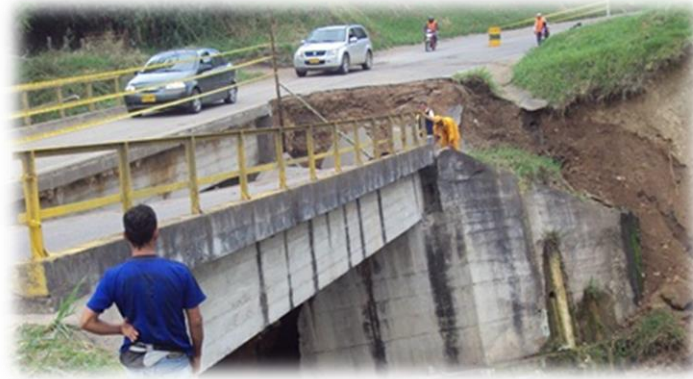
Figura 1.6 Desplome del estribo (tomado de http://www.lanacion.com.co/index.php/noticias-regional/pitalito/item/122740-se-desplomo-el-puente-de-guachicos )
