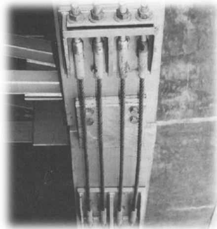
Figura 1.15 Rehabilitación de la viga utilizando cables para restringir el movimiento en las juntas. (Tomada de Priestley et al., 1996)
