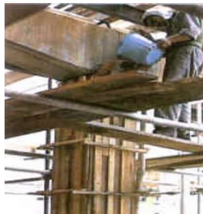
Figura 2.4 Colocación de concreto convencional en el encamisado
