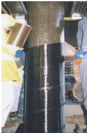
Figura 2.9 Rehabilitación de una columna mediante aplicación de fibras de carbono
