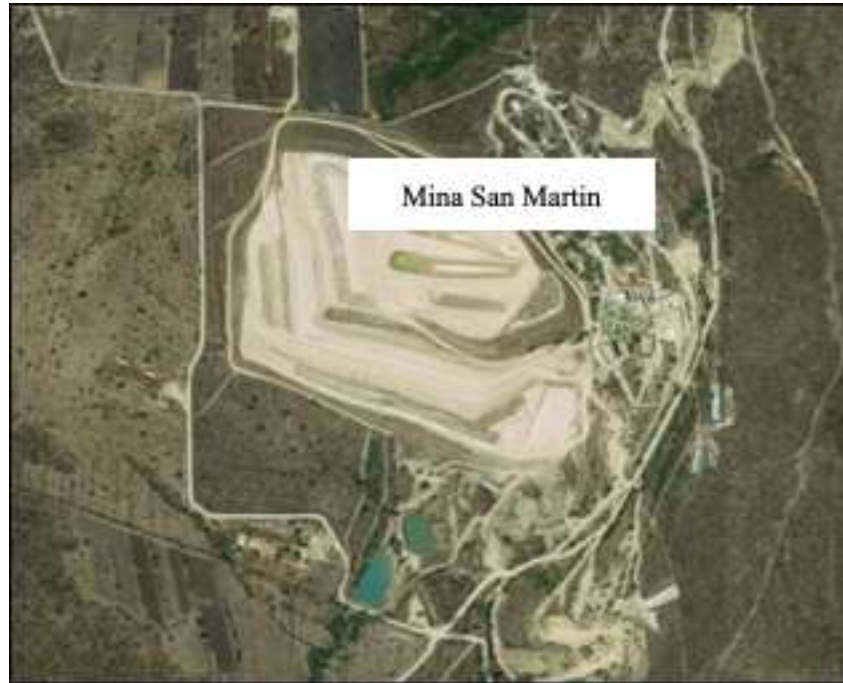
Fig. 2.11 Presa de jales en Peña de Bernal, Querétaro, México [110].
