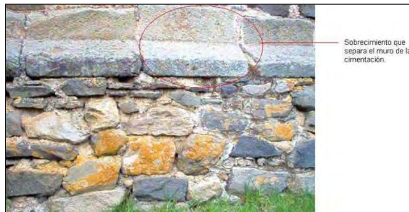
Figura 8. Detalle del sobrecimiento de la nave del templo.
