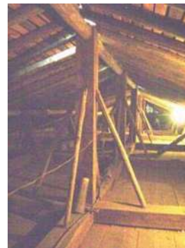
Figura 12. Caballete soportado por puntales a 4 y 4.5 metros.
