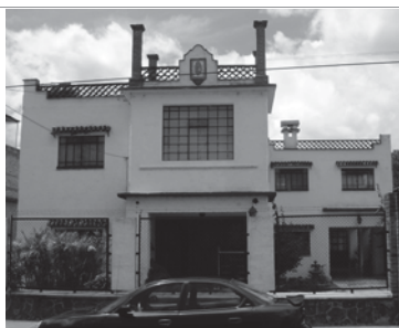
Imagen 47. Casa en la calle Fernando Montes de Oca No. 197, en la Chapultepec Norte. Lo mismo ocurre en esta casa, la estructura es ligera (en relación, claro, a los muros de cantería y adobe, viguería de madera y que se empleaban en la construcción en la ciudad).
