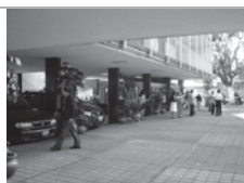
Imagen 75. Vista de la planta baja del edificio de las aulas, una planta libre sostenida en pilas (Parte del discurso de Le Corbusier)
