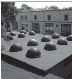
Imagen 55. Exterior de la zona de servicios
