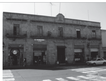
Imagen 63. Edificio Ruiz, proyectado y construido por los hermanos Ramírez Bernal en 1959. El exterior del edificio se asimila a la ciudad con un lenguaje histórico, mientras que en el interior se construyó con materiales modernos.
