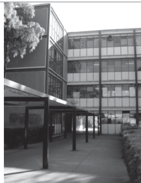
Imagen 53. Unidad Zacatenco, ciudad de México. Vista del pasillo cruzando el edificio tipo
