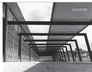
Imagen 83. Pasillo cubierto en la zona de talleres
