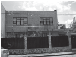
Imagen 38. La casa en la calle Juan de la Barrera No. 31, colonia Chapultepec Norte, que es una de tres casas construidas bajo el mismo principio de distribución de los espacios de la casa y el predio. También es representativa de la transformación de la vivienda a finales de los cincuenta, y, como es notorio, siguió en este tipo de vivienda dominando el macizo sobre el vano con ligeros desfases en los muros exteriores, y zonas exteriores protegidas por un voladizo de concreto, como ocurrió en el acceso a esta vivienda. Otro rasgo importante fue que en este tipo de vivienda empieza a usarse el azulejo y la piedra como fachaleta, sin que en esto hubiera una preocupación estructural, más bien una idea de la durabilidad de estos materiales.
