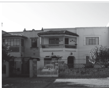
Imagen 46. Dos casas del conjunto de Las Palmas, en la avenida Acueducto No. 670 y 660. Se puede observar la ligereza de la estructura en estas viviendas, en que los muros no sobrepasan los 21 centímetros de espesor, y las losas del entrepiso y cubierta que simplifican el sistema constructivo reduciendo la escala de la vivienda.
