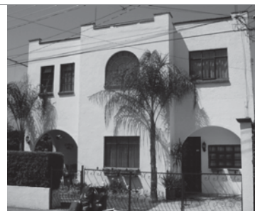
Imagen 48. Casa en la calle Vicente Suárez 54, en la colonia Chapultepec Norte. De este modelos se construyeron 20 casa con variantes formales en las viviendas de las esquinas, y en los remates en los pretilos. En este caso la cochera y la terraza sobre la cochera fueron modificadas cerrándose y cubriéndose respectivamente, según la manera de apropiación del propietario de cada casa.
