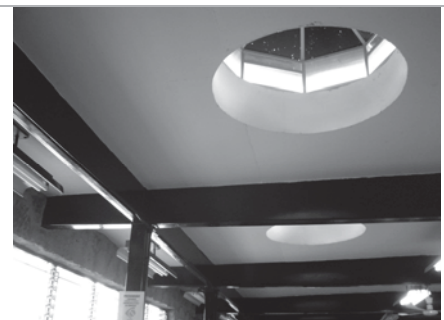
Imagen 57. Solución de los tragaluces
