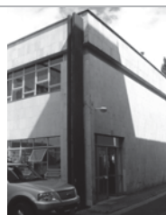
Imagen 125. Vista de zona administrativa
