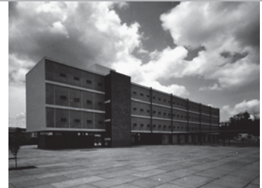
Imagen 74. Fachada norte del edificio de aulas
