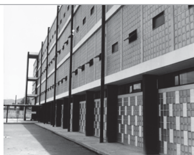
Imagen 82. Vista norte del edificio de aulas
