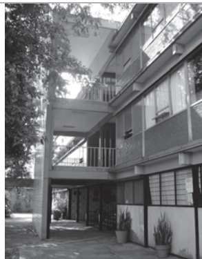
Imagen 52. Normal Urbana Morelia. Vista de la solución de escalera en el primer módulo de aulas
