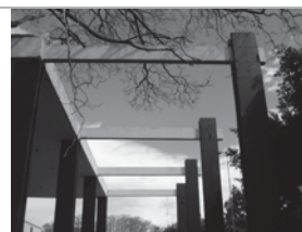
Imagen 126. Vista de Cubierta de acceso a la clínica
