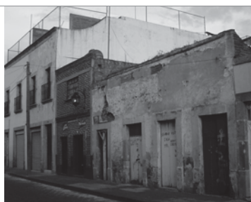
Imagen 61. La casa habitación en la calle Allende no. 1127, reconstruida con tabique y refuerzos de concreto, junto a un dos casas con locales comerciales, en las que se identifica el tipo de edificación que realizaron los ingenieros civiles de la UMSNH, y abajo una vivienda construida con materiales empleados para la construcción antes de la llegada de los materiales modernos.
