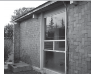
Imagen 93. Hay varios muros recubiertos con ladrillo. Este detalle fue usado en la Escuela Normal Urbana
