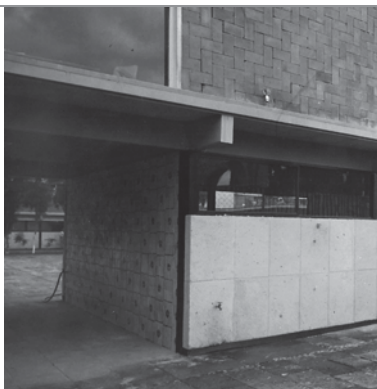
Imagen 77. El edificio administrativo de la Escuela Normal fue recubierto con ladrillo, azulejo y laminado de cantería, los que, por el volumen, seguramente fueron traídos de otras regiones del país.
