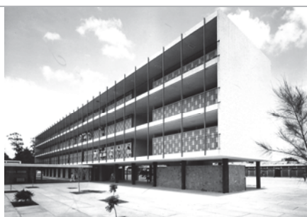
Imagen 81. Vista sur del edificio de las aulas, desde el acceso
