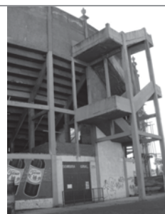
Imagen 82. En el caso de la Plaza Monumental de Morelia, la estructura quedó a la vista desde el entorno urbano.
