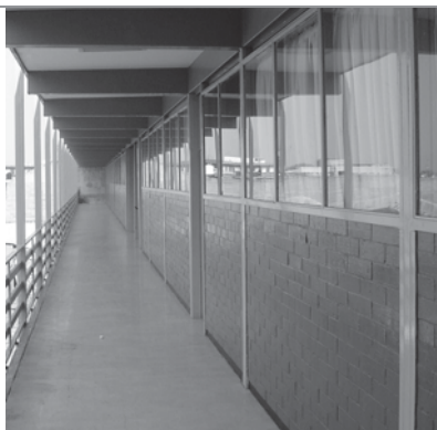
Imagen 78. En el tercer edificio de la Escuela normal la división entre la circulación y las aulas se resolvió con un muro divisorio de tabique extruido que fue traído desde otro lugar de la República Mexicana.
