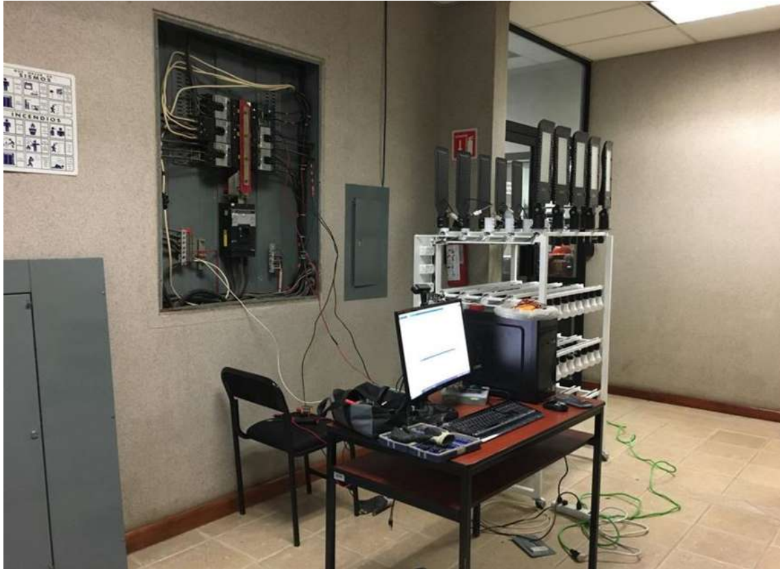
Figura 5.2: Implementación del experimento en el laboratorio con el generador fotovoltaico.
