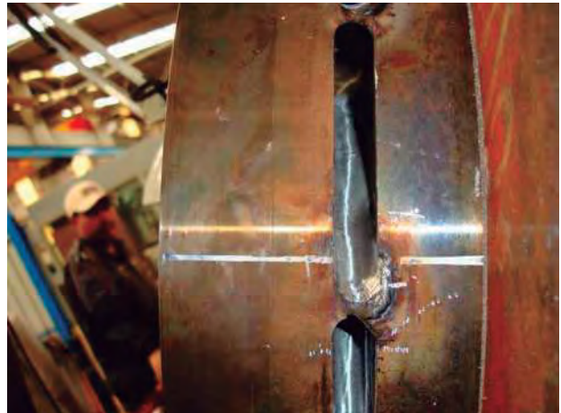
Foto 1.2 Se muestra el espacio para soldar los álabes.
