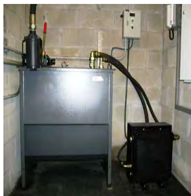
Fig. 1.4 Conjunto de propulsión hidráulico [24]
