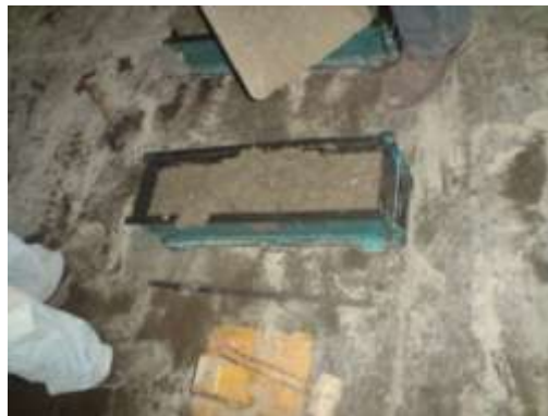
Figura . Llenado del molde en capas de concreto.
