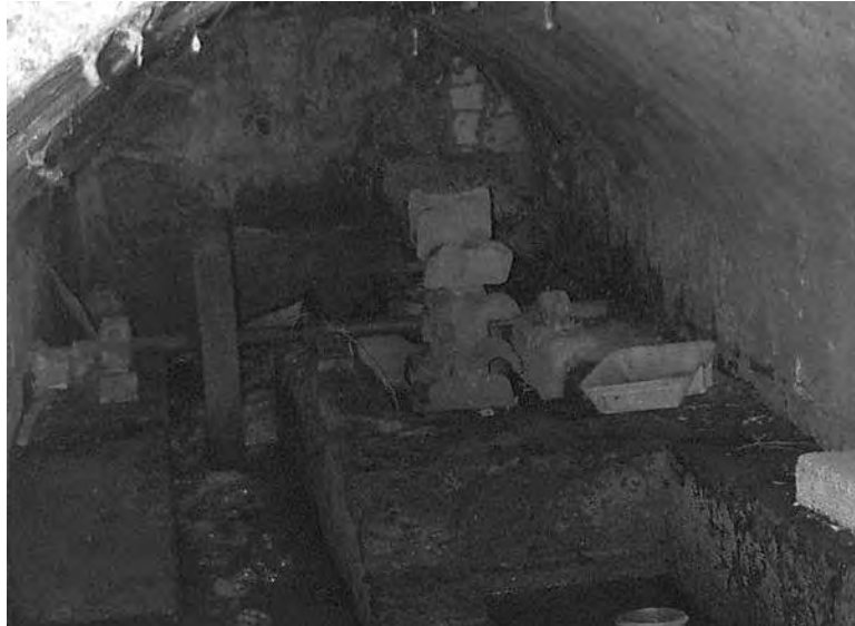
Fig. 23 Vista del Cárcavo donde se aloja el rodezno de la hacienda de Guadalupe. Fotografía MGMR.
