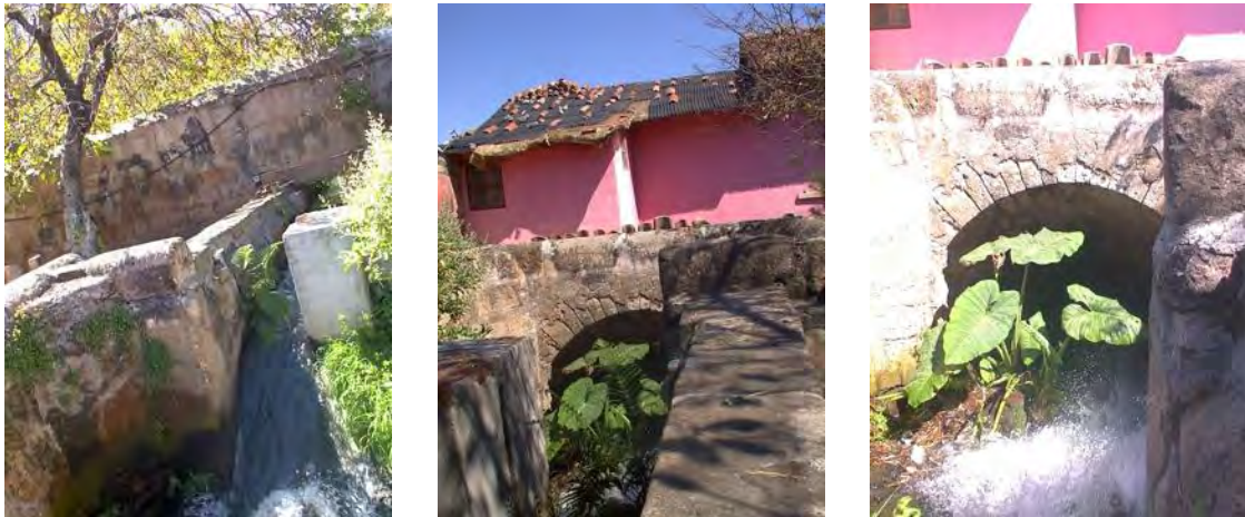
Fig. 22 Cubo por el cual el agua cae hacia el rodezno en la hacienda de Guadalupe. Fotografías MGMR.
