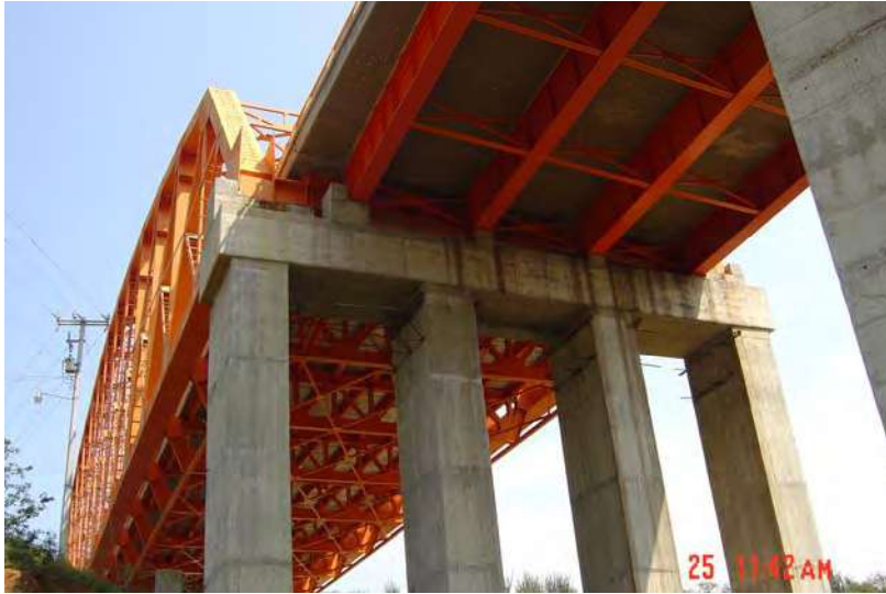
Figura 1.14 Claro del apoyo 2 al 3 del puente Pinzandarán
