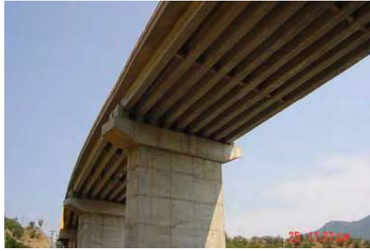
Figura 1.16 Claro del apoyo 3 al 6 del puente Pinzandarán
