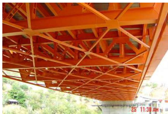
1.8 Armadura inferior del puente Pinzandarán en el primer y sexto claro
