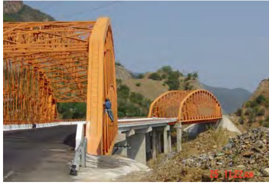
Figura 1.11 Armaduras laterales de puente Pinzandarán
