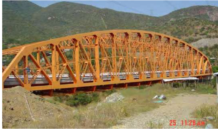
Figura 1.9 Armadura paralela al eje del puente
