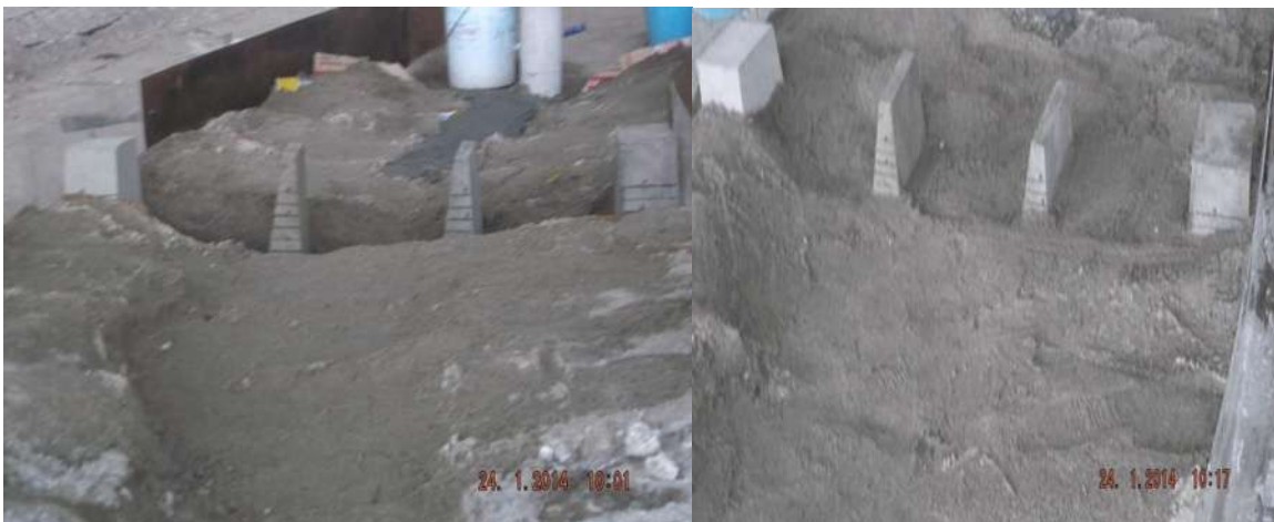
Figura 5.24 a) Pilas y estribos colocados en la zanja; b) Pilas y estribos rellenos hasta los niveles de las secciones 0+360 a 0+340.
