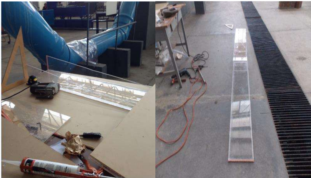
Figura 6.7 Construcción de la plataforma de transición.
