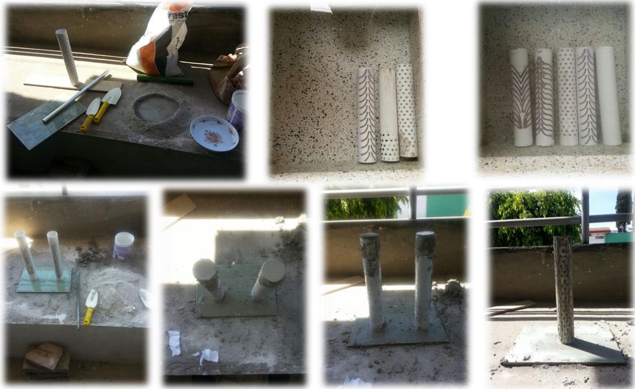
Figura 6.25 Procedimiento del colado de las pilas.
