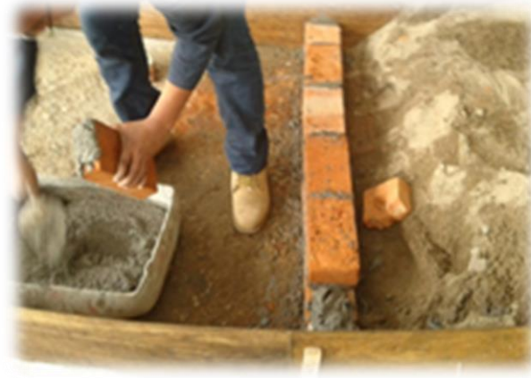
Figura 4.16 Colocación de muro de tabique para control del flujo.
