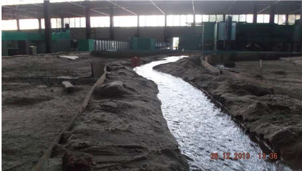
Figura 5.15 Erosión en los bordos del río San Juan.
