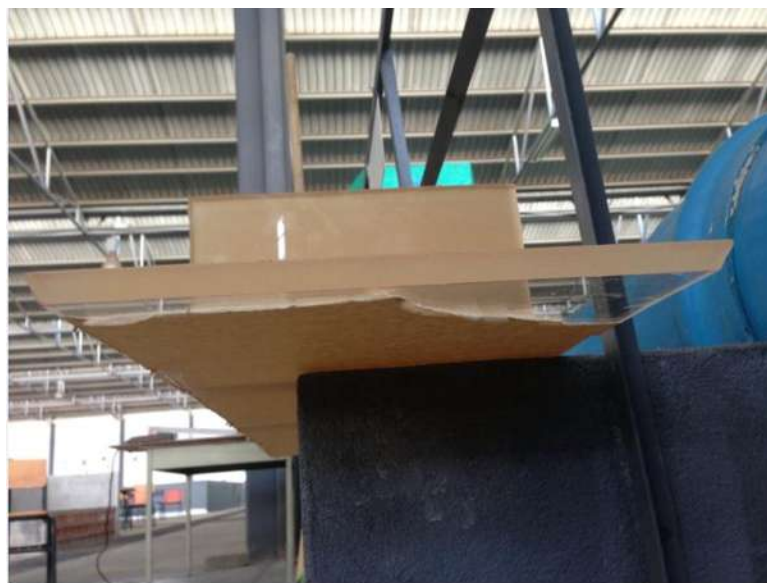
Figura 6.5 Construcción del vertedor tipo Rehbock
