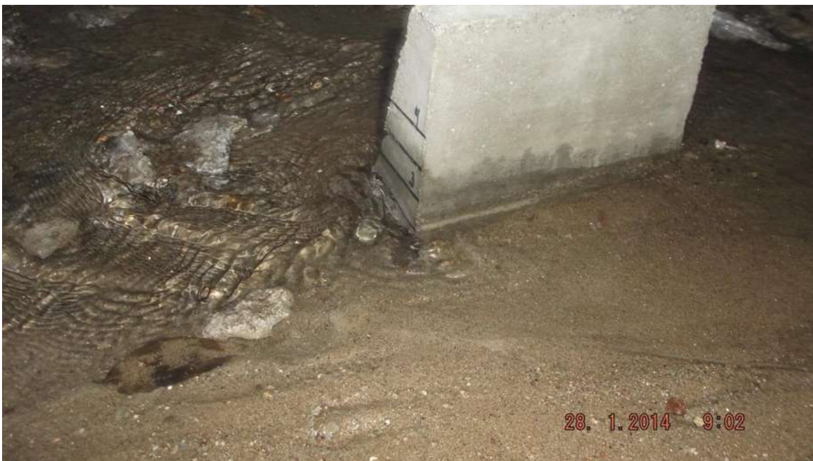
Figura 5.30 Segmentos de paredes depositados frente a la pila 1.
