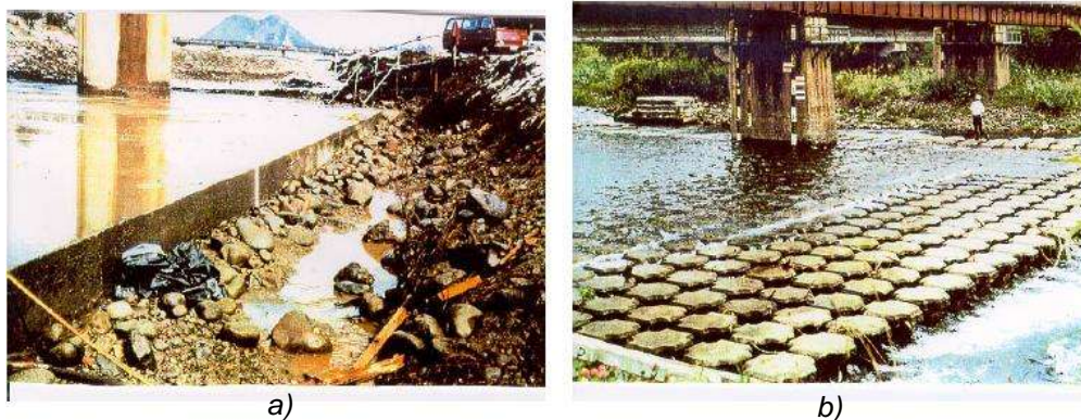
Figura 2.22 Revestimiento del lecho con bloques de protección. a) Bloque único fundido in situ; b) Bloque formado por varias unidades.
