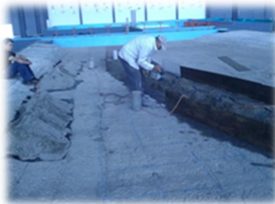
Figura 4.13 Ranuración del piso para la colocación de las paredes del río.
