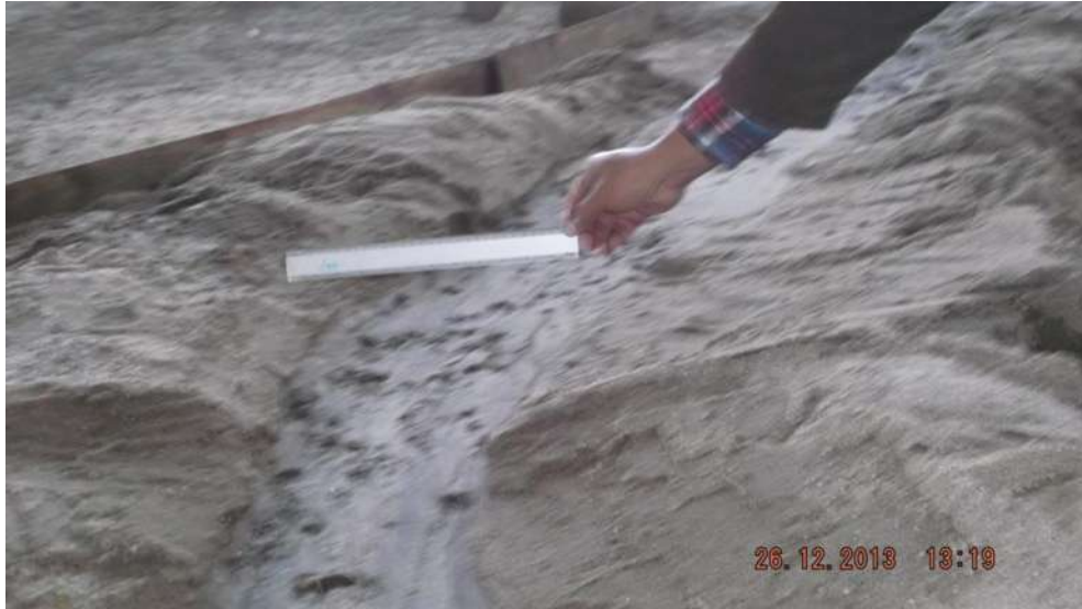
Figura 5.13 Medición de borde en la sección 0+780.
