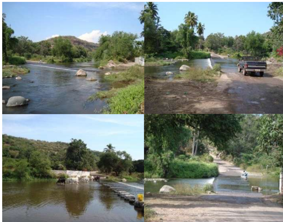
Figura 1.22 Fotografías del sitio por el cual está proyectado el puente.
