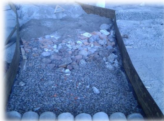
Figura 4.15 Colocación del material de relleno.
