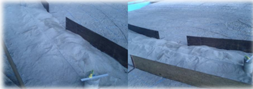
Figura 4.10. Nivelación de la arena para las pendientes.
