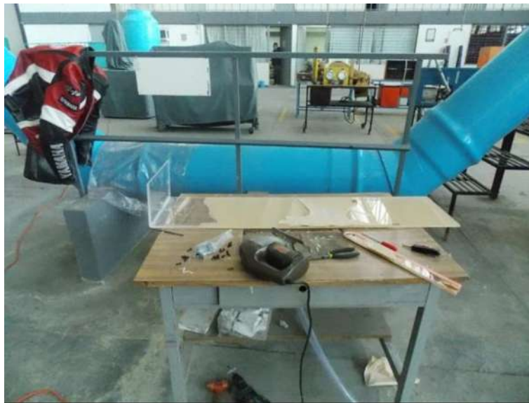
Figura 6.4 Construcción de foso de socavación.
