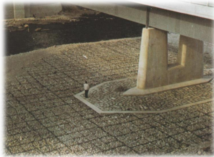
Figura 2.14 Ejemplo de Obra de Protección a base de enrocado y gaviones
