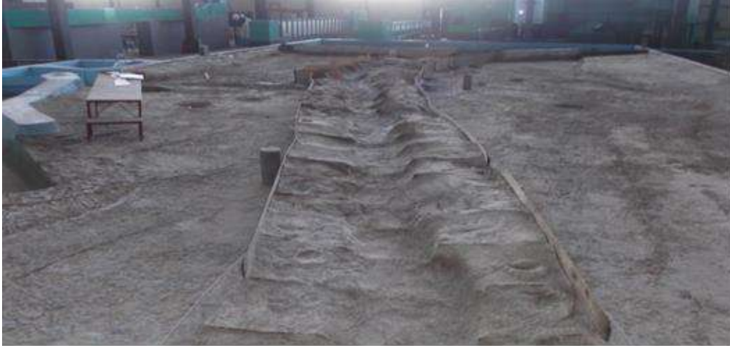
Figura 4.19 Secciones Transversales del río terminadas.
