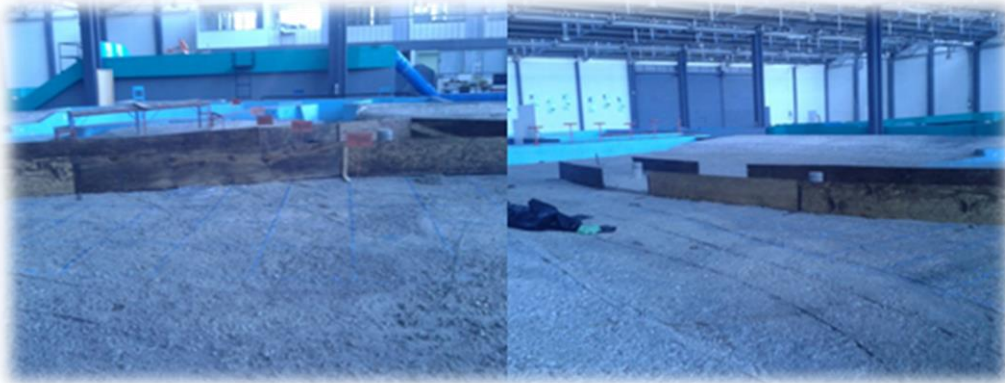
Figura 4.8 Colocación de las paredes del río San Juan.
