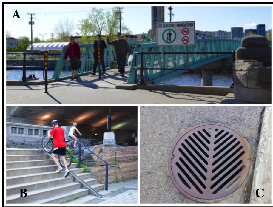
Figura 2.8 Obras complementarias. A) Paso peatonal y ciclista; Montreal, Ca. B) Riel de apoyo ciclista en escaleras; Ottawa, Ca. C) Alcantarilla adecuada para ciclistas; Montreal, Ca
