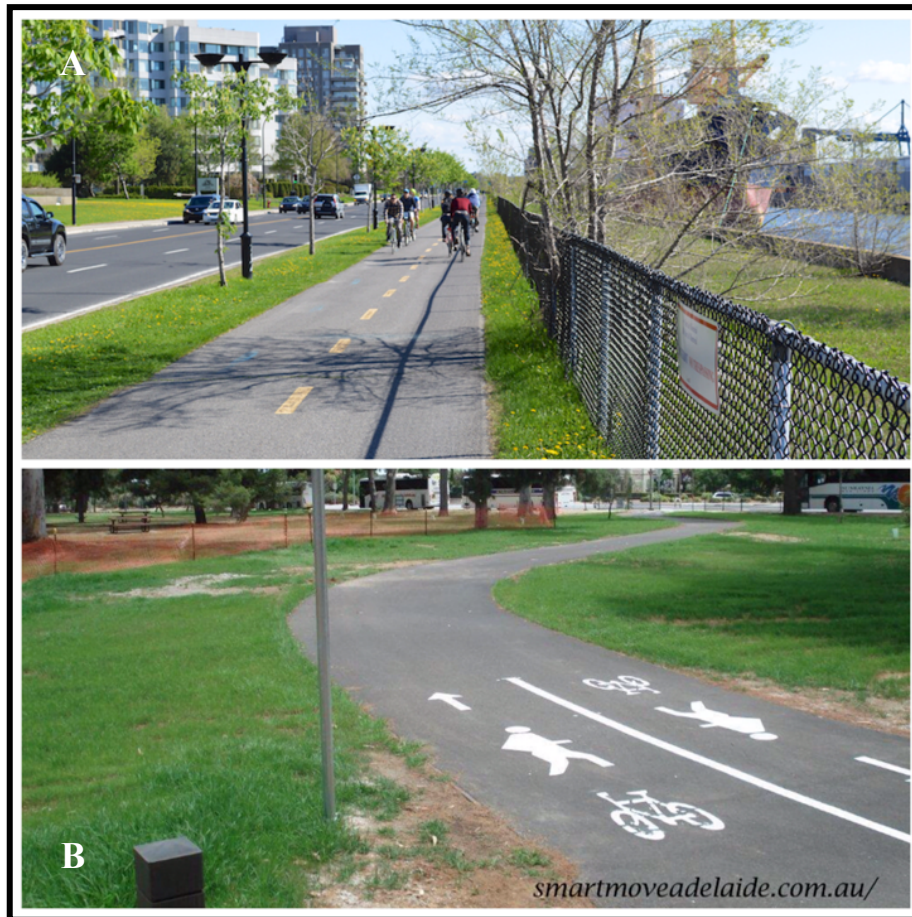
Figura 1.5 Ciclovías segregadas Fuente: A, Personal; B, smartmoveadelaide
