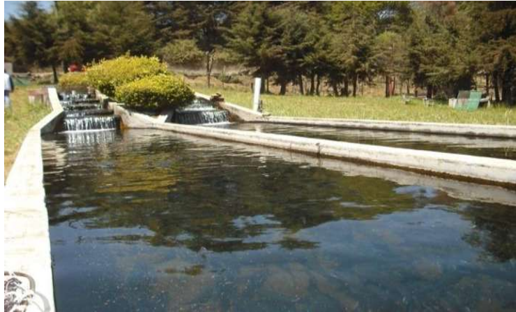
Figura 3. 5. Estanquería de concreto
