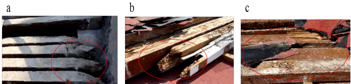
Figura 11. 5. Condiciones de las cabezas de las vigas de la Catedral Metropolitana de Morelia (a, viguería sin terrado, b y c viguería retirada).
