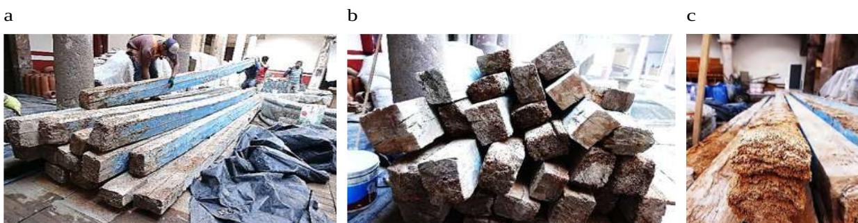
Figura 12. 5. Vigería del cuarto azul siendo retirada y colocada en el patio (a) selección del material para cortes y posible reubicación (b y c).
