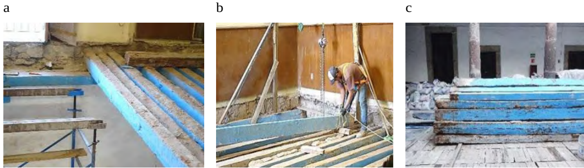
Figura 12. 6. Viguería del cuarto azul al momento de estar siendo desmontadas del edificio (a y c) y su colocación en el patio una vez que fue retirada (c).
