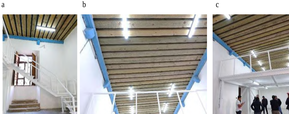
Figura 12. 14. Área de intervención del Palacio Federal ya terminada (a, b y c).
