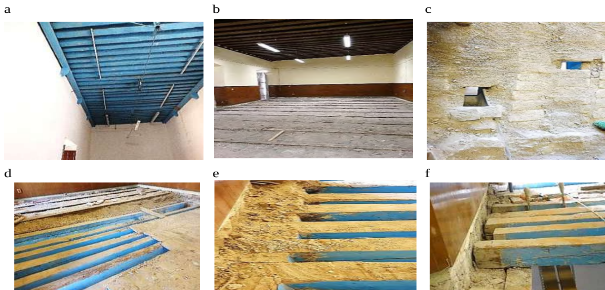
Figura 12. 7. Viguería del cuarto azul antes de ser retirado (a), después de retirar la duela superior (b), retiro del terrado (c), de enladrillado (d y e) y desmonte de vigas (f) del entrepiso.
