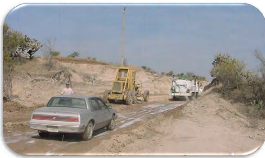
Imagen 2 Proceso de estabilización química (enzimas) de un camino (TECNOCAM).
