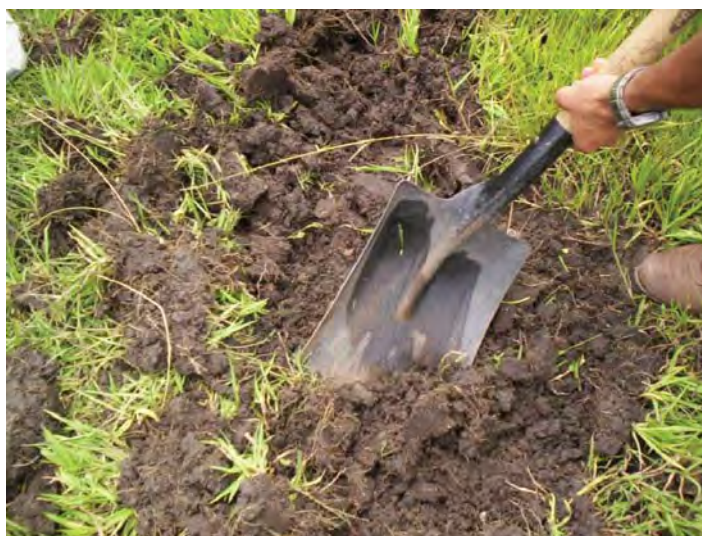
Imagen 3. 6 Despalme de la capa vegetal (material 1).
