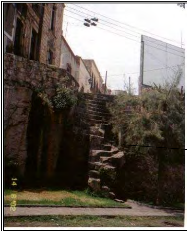
Imagen No 9 Esta fotografía corresponde a la calle de García Pueblita, en donde se pueden detectar los desniveles de terreno con un pronunciamiento mayor dado que es el lugar en donde se rompe la parte más elevada del banco de cantera que existía anteriormente y que formó parte de la huerta del convento. Los perfiles urbanos que podemos observar son calles con vivienda en forma escalonada de uno y dos niveles.
