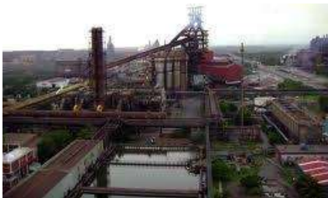
Ilustración 2.6.1.1. Siderúrgica de Lázaro Cárdenas, Michoacán.
