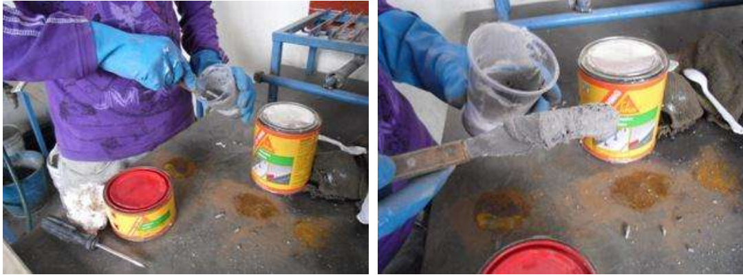
Ilustración 3.6.2.4.2. Elaboración de la mezcla del epóxico.
