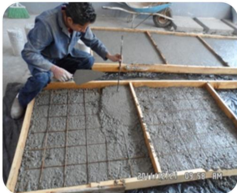
Ilustración 3.5.2.2. Losas de concreto, llenado de la segunda capa de concreto una vez colocada la malla electro soldada
