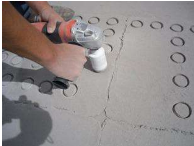
Ilustración 3.6.2.4.1. Perforación de las losas para la prueba de adherencia.
