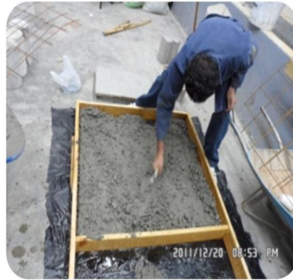
Ilustración 3.5.2.1. Elaboración de losas, llenado de la primera capa de concreto.
