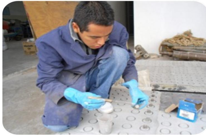
Ilustración 3.6.2.4.3. Pegado de los discos de acero en el recubrimiento de mortero.
