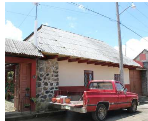
Fig. 95. Exterior de V-2. Fotografía propia. Tomada el 04 de julio de 2020.
