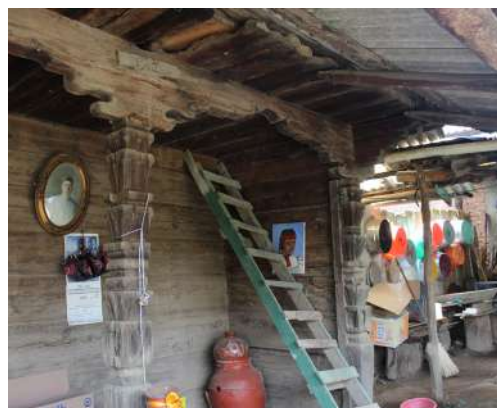
Fig. 100. Pórtico y escalera a tapanco en troje de V-3. Fotografía propia. Tomada el 04 de julio de 2020.
