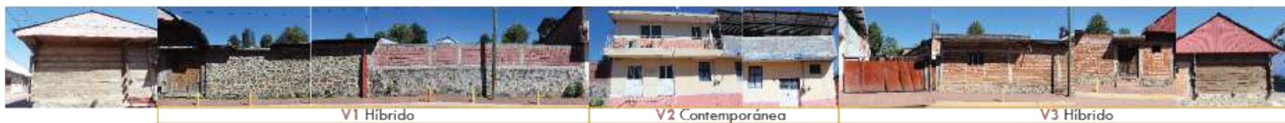
Fig. 60. Larguillo uno de calle Libertad lado Norte. Elaboración propia. Realizado el 21 de abril de 2020.
