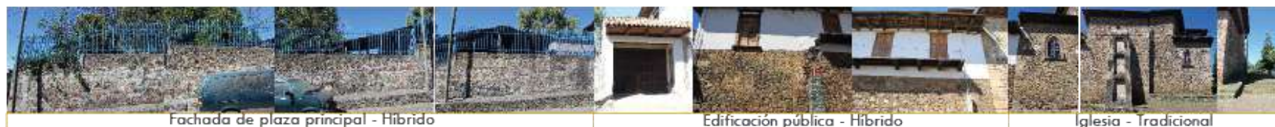
Fig. 66. Larguillo dos de calle García lado Poniente. Elaboración propia. Realizado el 21 de abril de 2020.
