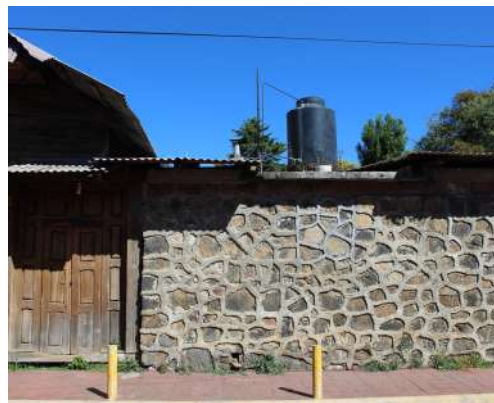
Fig. 22. Acceso actual. Fotografía propia. Tomada el 11 de febrero de 2020.
