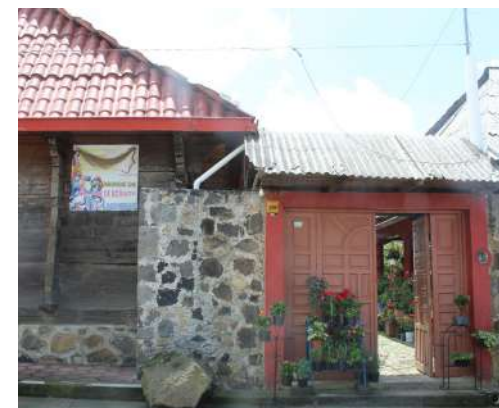
Fig. 94. Acceso a V-2. Fotografía propia. Tomada el 04 de julio de 2020
