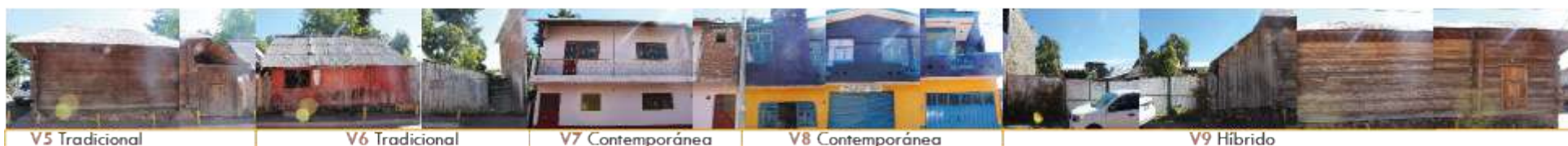
Fig. 56. Larguillo dos de calle Lázaro Cárdenas lado Oriente. Elaboración propia. Realizado el 02 de marzo de 2020.
