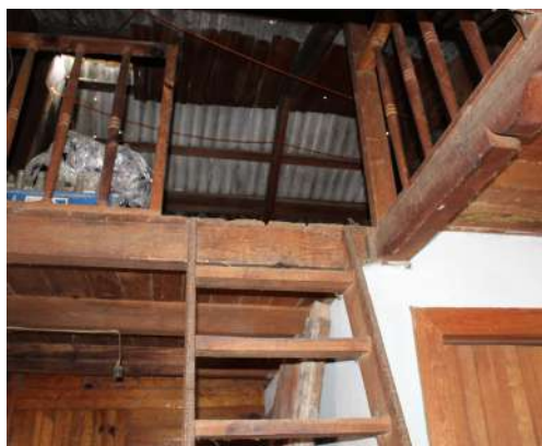
Fig. 88. Área de guardado planta alta en V-1. Fotografía propia. Tomada el 04 de julio de 2020.
