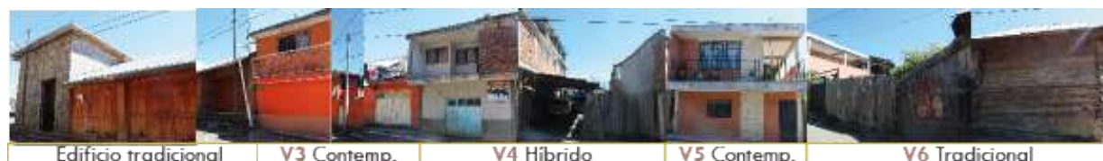
Fig. 68. Larguillo dos de calle García lado Oriente. Elaboración propia. Realizado el 21 de abril de 2020.
