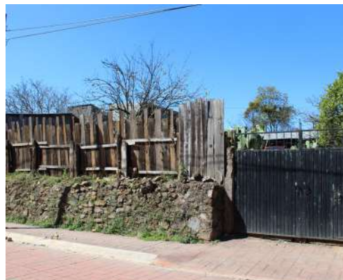
Fig. 23. Acceso actual. Fotografía propia. Tomada el 11 de febrero de 2020.
