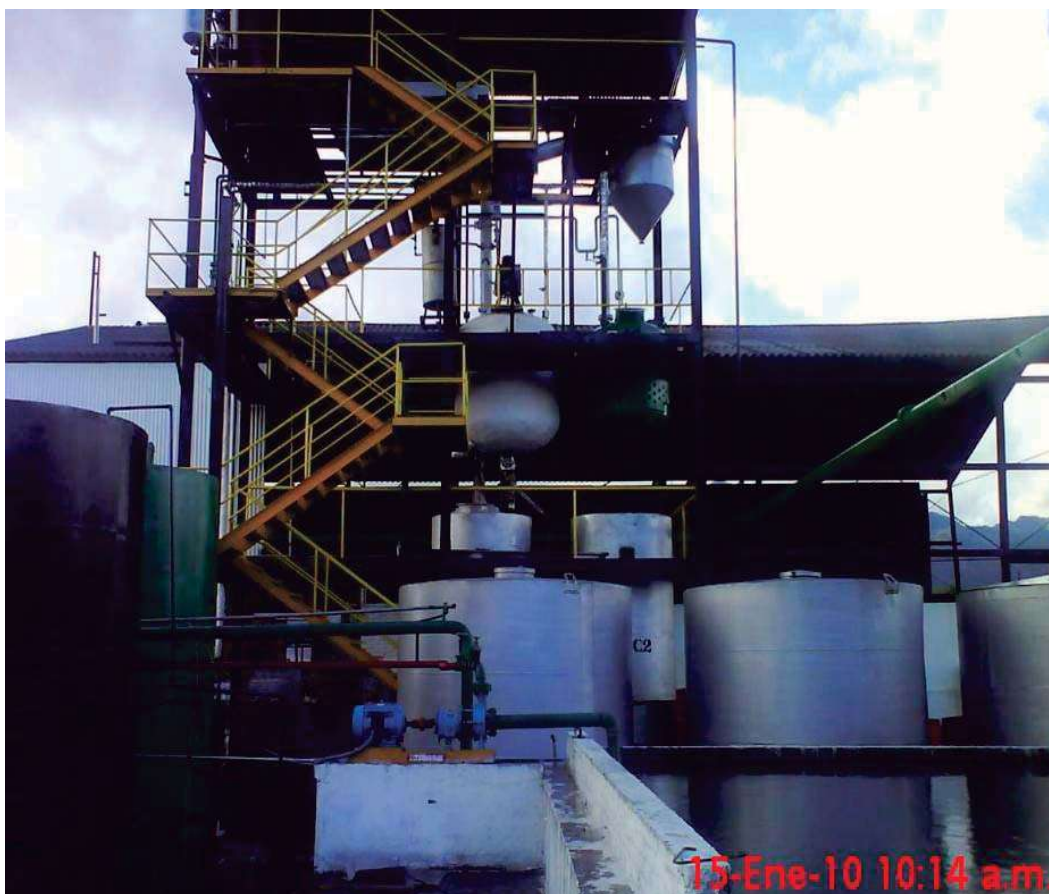
Figura2.1. Nave de proceso de derivados de resina de pino de alto valor agregado, RESINERA LAZARO CARDENAS AR DE IC.
