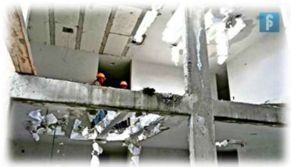
Figura 19 Demolición de Techos. Arispón y Vila (2006). Recuperado de https://www.mc-mutual.com
