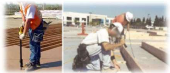
Figura 40 Uso de Herramienta. Rosel L (2005). Recuperado de http://www.acpnavarra.com ManualErgonomiaConstruccion-042008.pdf
